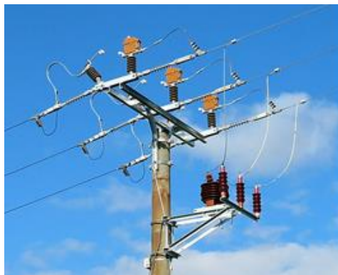
Obr. 2.4 Dálkově ovládaný úsekový odpínač s olejovými komorami pro zhášení oblouku
