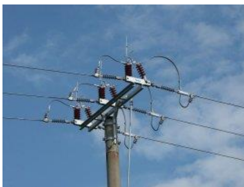
Obr. 2.3 Úsekový odpínač růžkový
