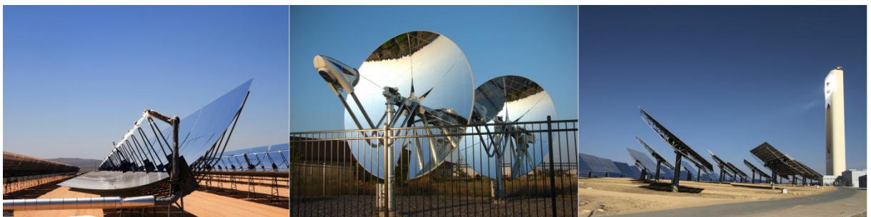
a) b) c) Obr. 3.6: Ukázka jednotlivých typů sběračů: a) sběrače se zrcadly tvaru parabolického válce, b) sběrače se zrcadly tvaru paraboloidu, c) Heliostaty [20]
