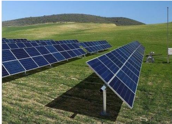
Obr. 32: Jednoosý polohovací systém [24]
