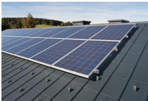
Obr. 31: Pevná instalace FV panelů [23]
