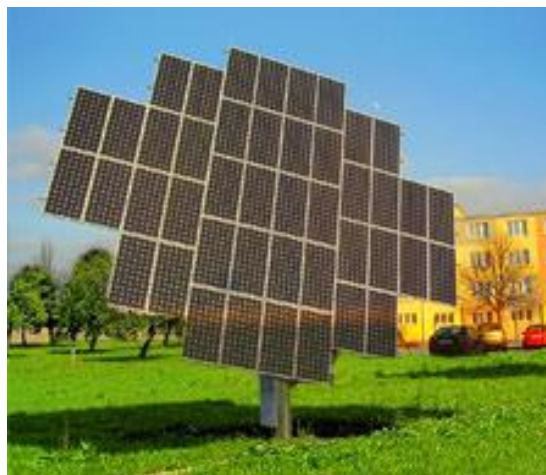
Obr. 33: Dvouosý polohovací systém [25]
