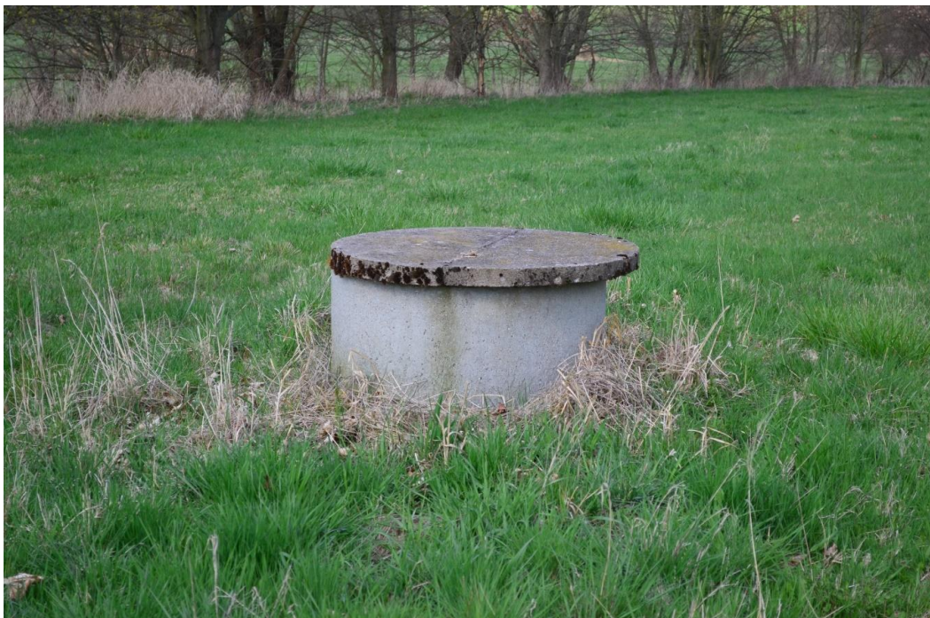
Obr.č. 2.3 Meliorační šachta
