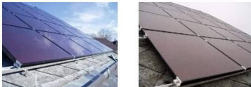
Obr. 1.11 Amorfnní krystalický článek - za slunečného počasí a za deště [10]
