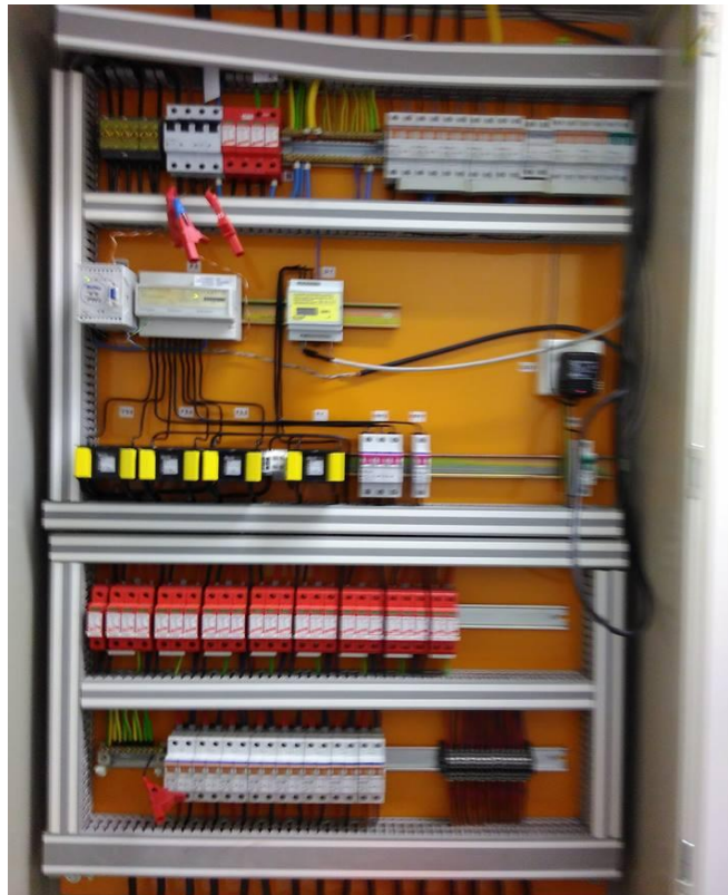
Obr.2.5 Rozvaděč systému pro síť nn [vlastní zdroj ]
