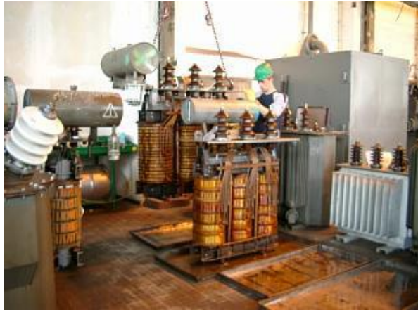
Obr. 1.2 Demontované jádro transformátoru s vinutím
