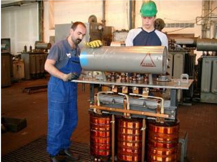
Obr. 4.3 Demontáž jádra transformátoru
