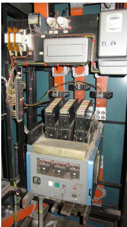
Obr. 4 Ilustrační fotografie přívodního jističe [1]
