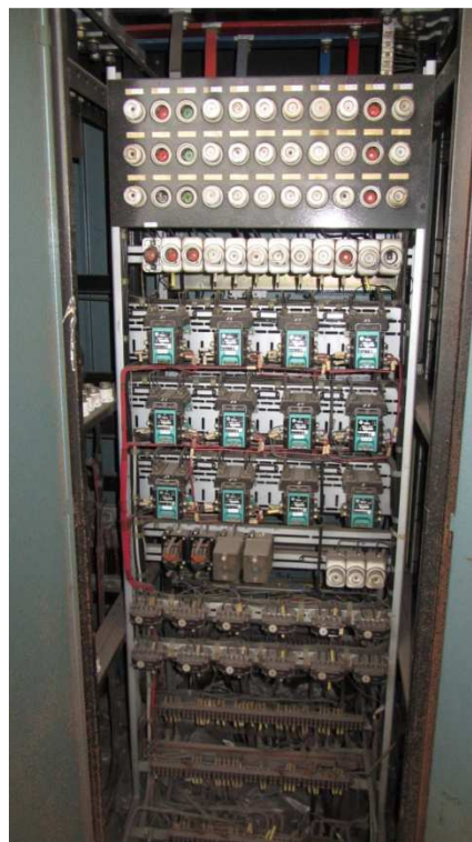
Obr. 13 Příklad stávající výzbroje pro servopohony [1]
