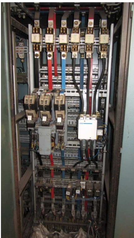
Obr. 12 Příklad stávající výzbroje pro čerpadla [1]
