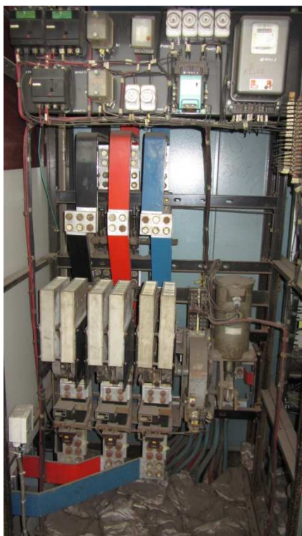
Obr. 7 Ilustrační fotografie přívodního jističe [1]
