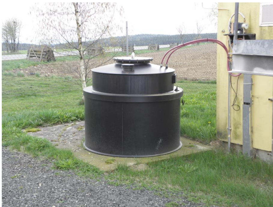
Obrázek 4: Dvouplášťová nádrž na železité soli
