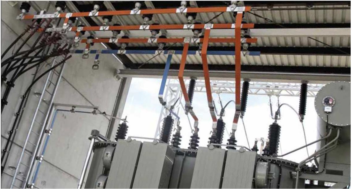
Obr. 2.7 Ploché hliníkové přípojnice v praxi
