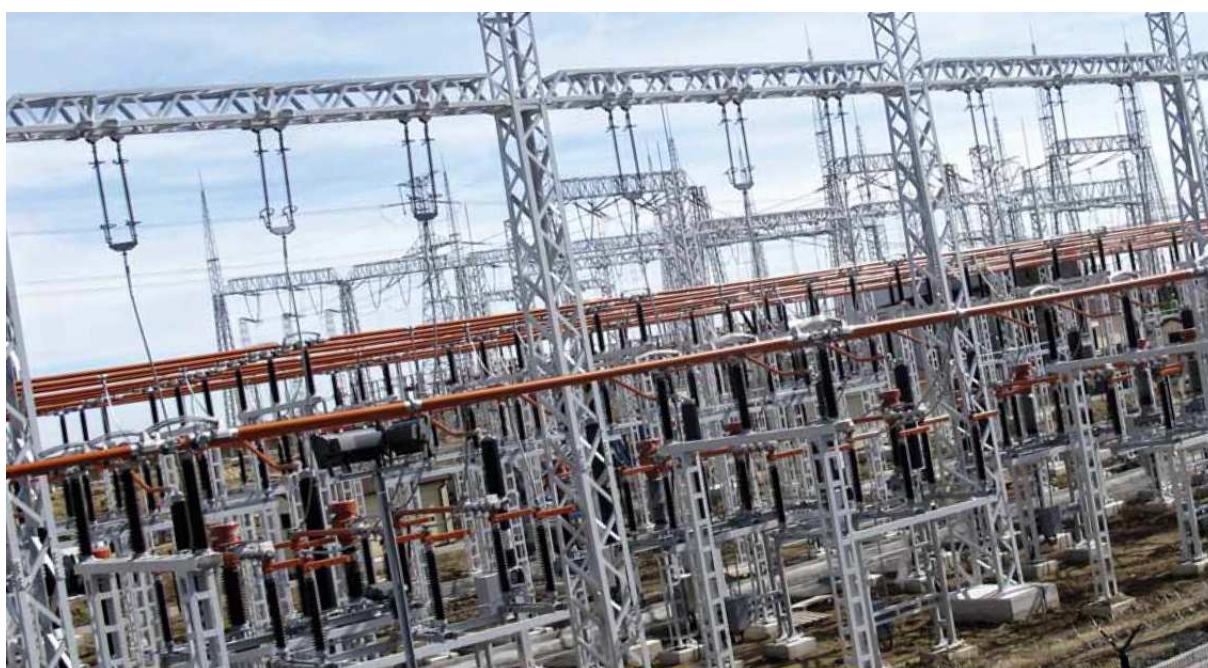
Obr. 2.9 Trubkové hliníkové přípojnice v praxi 3
