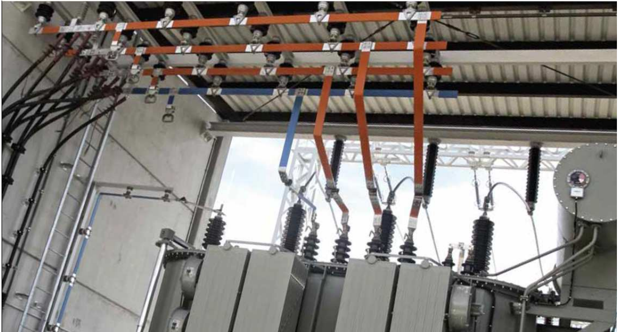
Obr. 2.7 Ploché hliníkové přípojnice v praxi
