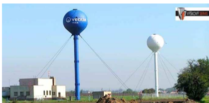
Obr. č. 15: Vodojemy
