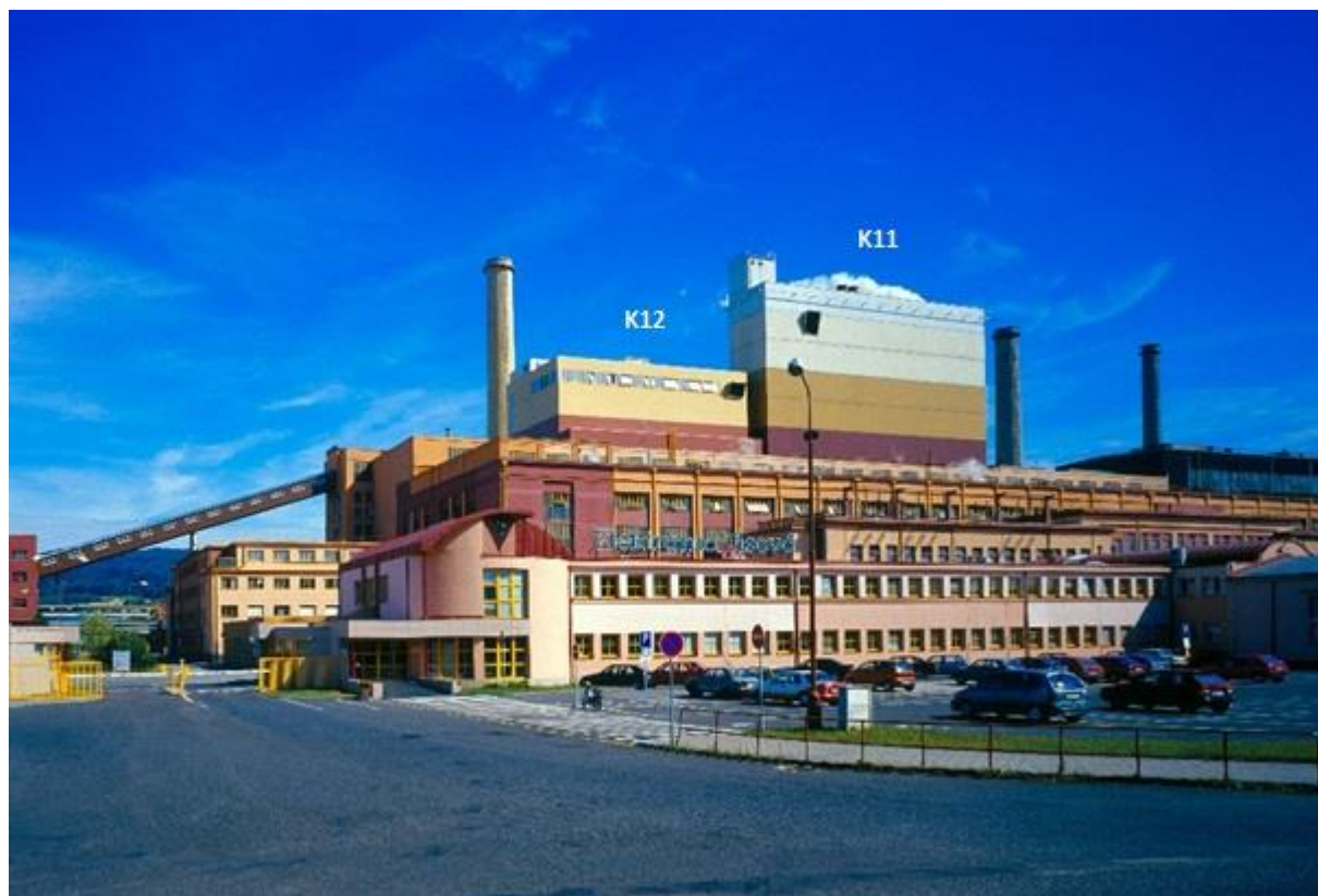
Elektrárna Tisová – hlavní brána a vřátnice podniku ( budovy K11 a K12 označeny na obrázku ). Zdroj: [17]
