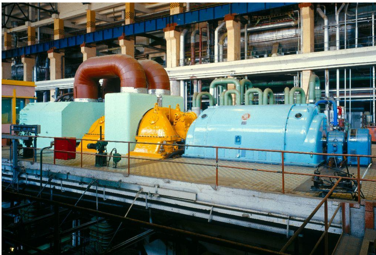
Elektrárna Tisová – strojovna – turbogenerátor č. 2. Zdroj: [17]
