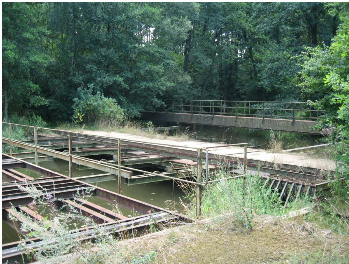
Obr. č. 10: Pozůstatky železné opony na řece Odavě
