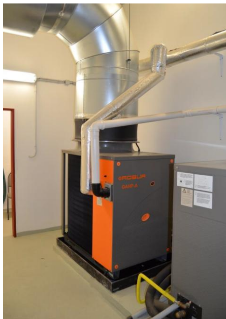
Kotelna po rekonstrukci
