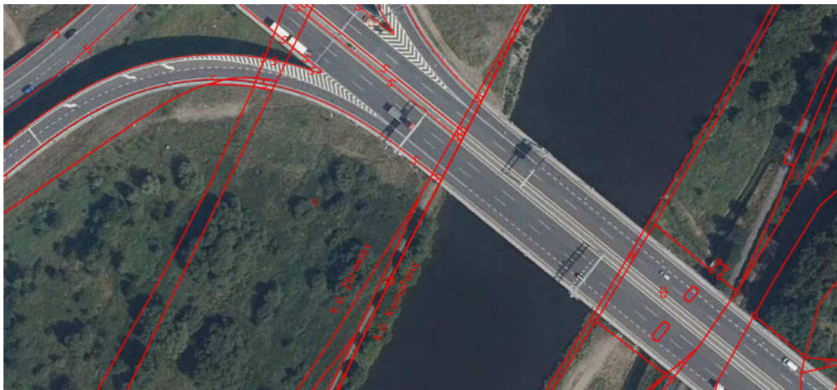
Obr.4.2.2.1 Most Pražského okruhu přes Radotínské údolí, kat. úz. Komořany a Zbraslav
