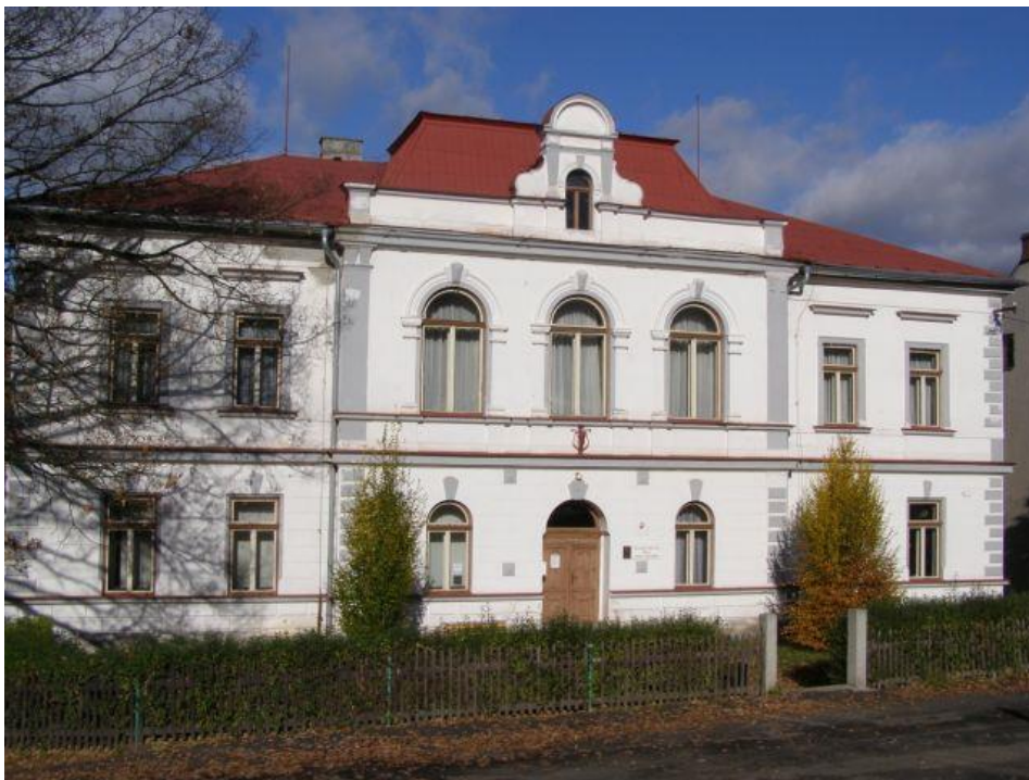
Příloha 1: Budova Základní umělecké školy Josefa Labitzkého v Bečově nad Teplou
