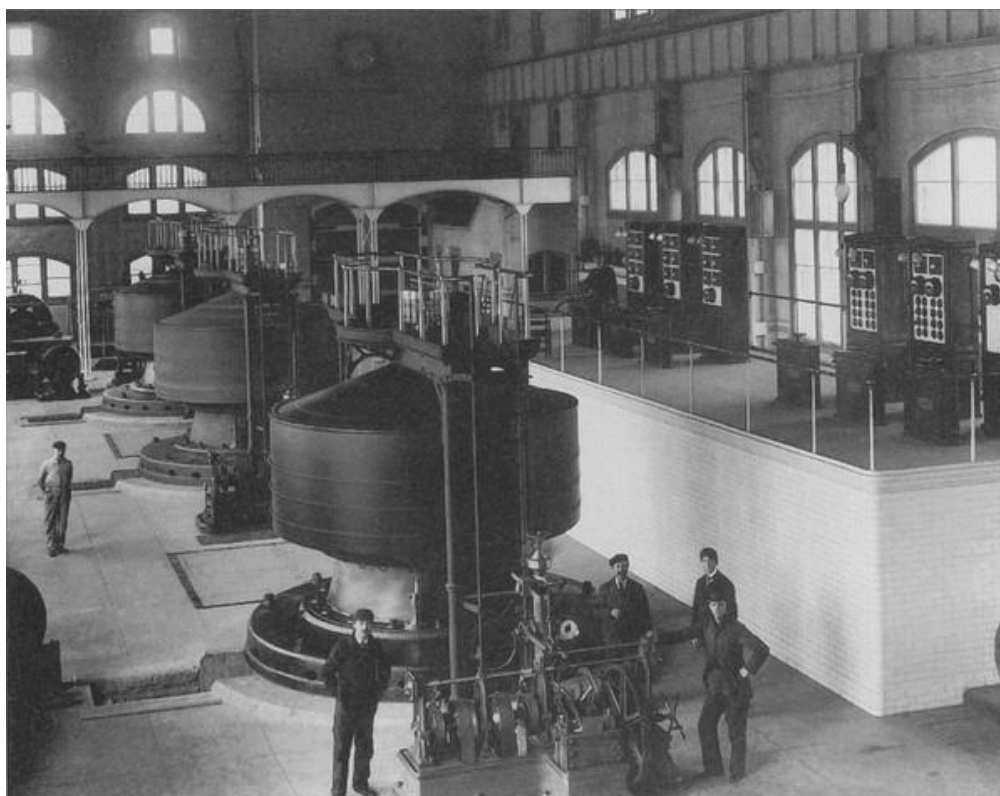
Obr. č. 10: Obří generátory v elektrárně u Niagarských vodopádů
