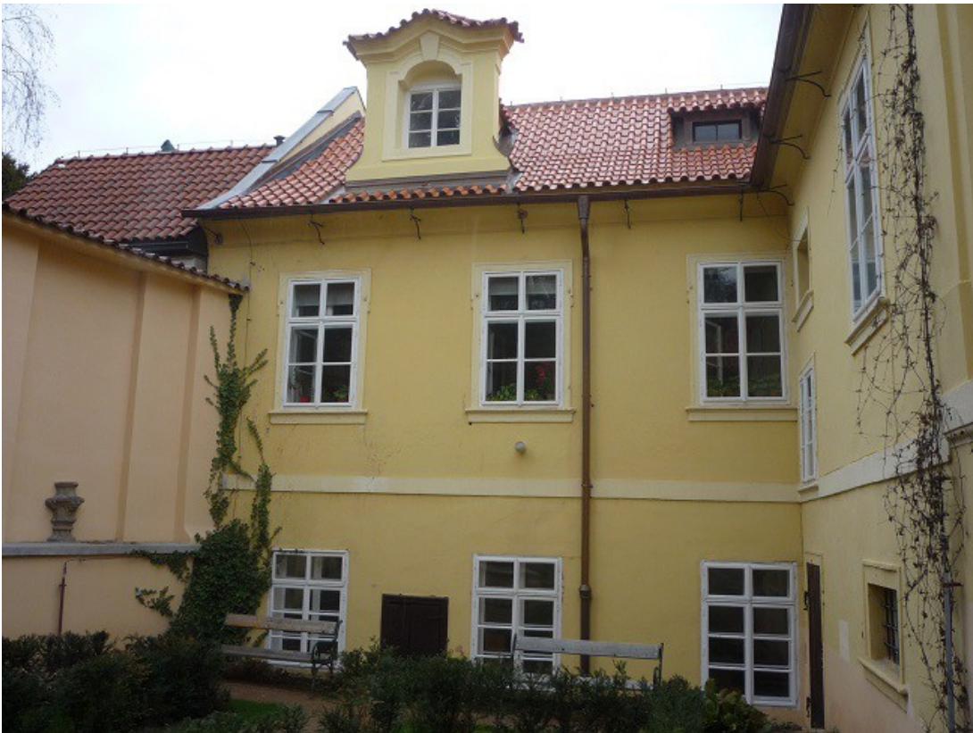
Obr. č. 7: Část budovy ve Vlašské ulici č. 9, kde pracoval J. Heyrovský. Praha 30. 3. 2016.
