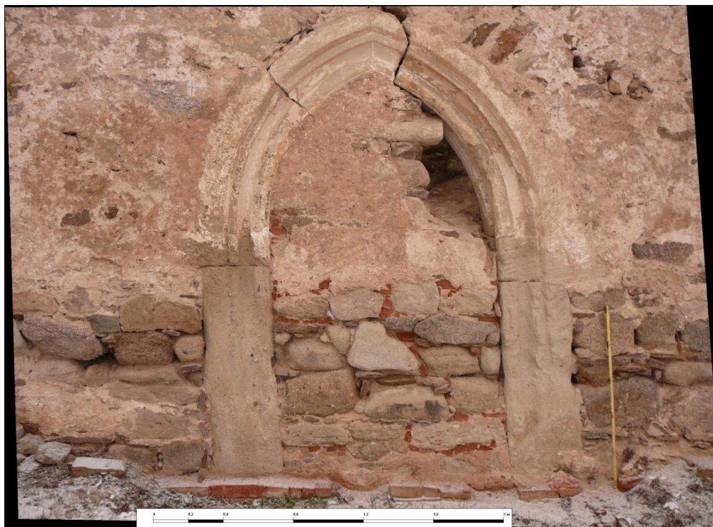
Obr. 7: Ostrovec – fotogrammetrie zazděného vstupního portálu
