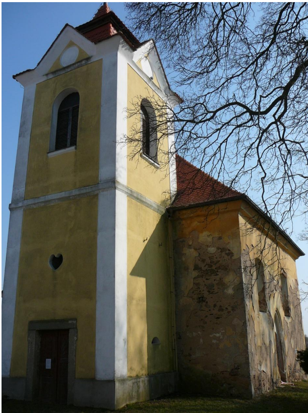
Obr. 12: Vysoká Libyně – pohled na věž na západní straně
