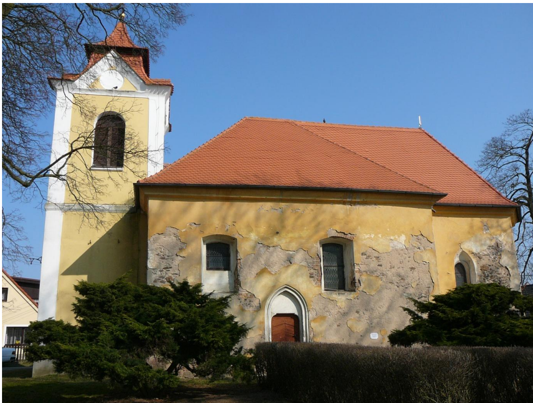
Obr. 10: Vysoká Libyně – pohled na hlavní průčelí
