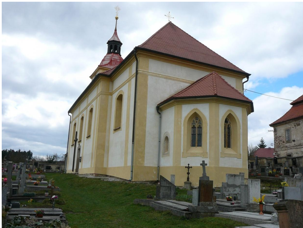
Obr. 29: Žebnice – pohled na celý kostel z východní strany
