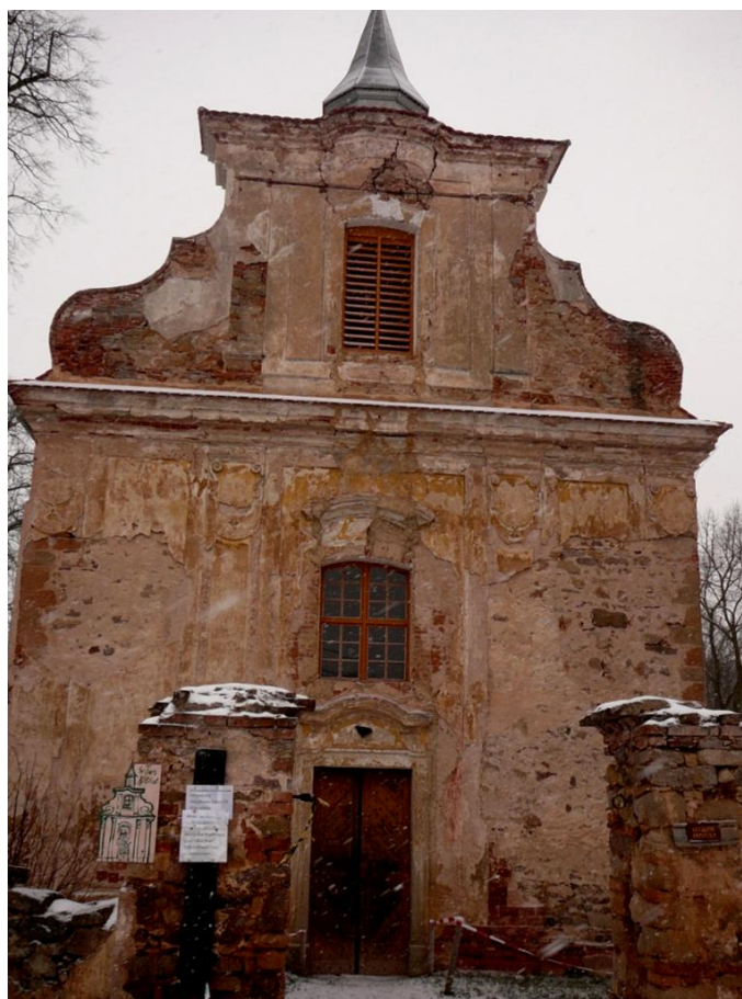
Obr. 3: Ostrovec – pohled na hlavní průčelí
