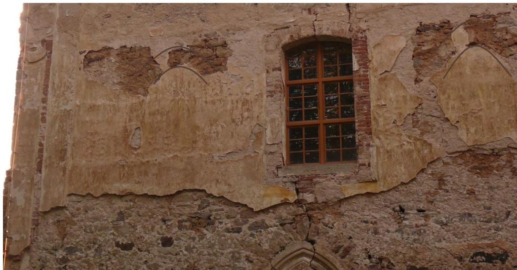
Obr. 4: Ostrovec – jižní průčelí se zvýrazněnými zalděnými gotickými okny
