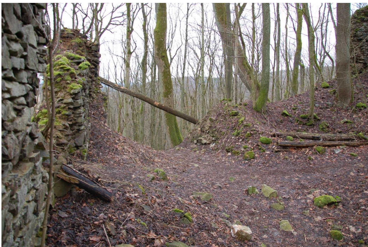
Obr. 36. Nový Herštejn. Prostor druhé hradní brány. Pohled z nádvoří části hradu (foto autor 30. 1. 2016).
