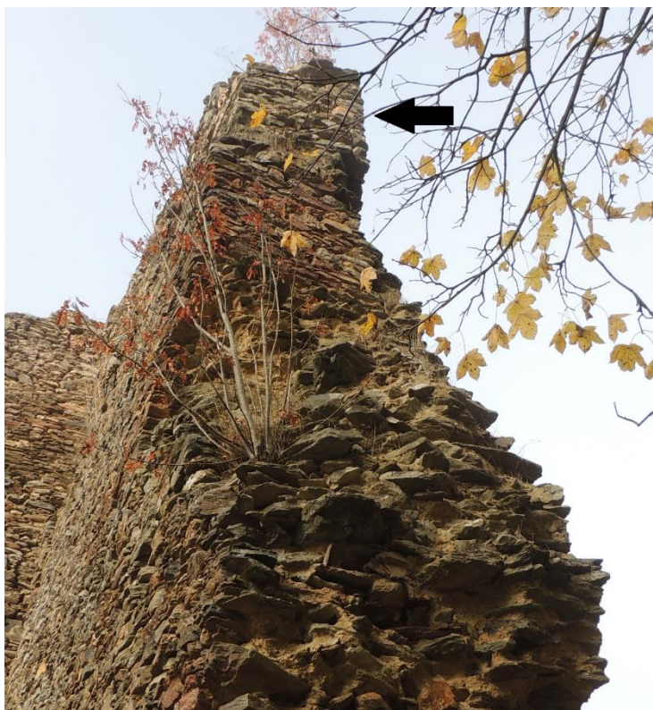
Obr. 123. Pajrek. Pozůstatek špalety okenního otvoru (označeno šipkou) v úrovni třetího patra severní zdi donjonu (foto 19. 3. 2016 a úprava autor).
