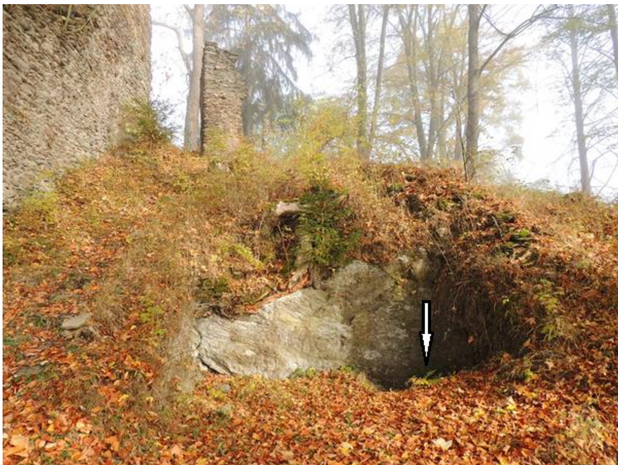
Obr. 134. Pajrek. Pozůstatky budovy (kuchyně?) jižně od schodišťové věže. V severovýchodním rohu (označeno šipkou) je do skály vylámaná cisterna na dešťovou vodu (foto 24. 10. 2016 a úprava autor).
