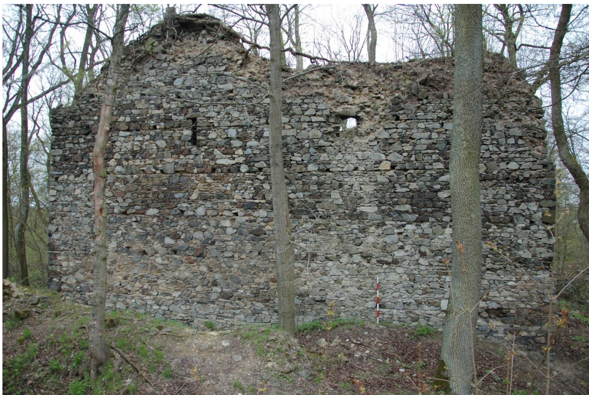
Obr. 20. Nový Herštejn. Vnější líc východní zdi donjonu. Lat' 1.4 m (foto 30. 1. 2016 autor).
