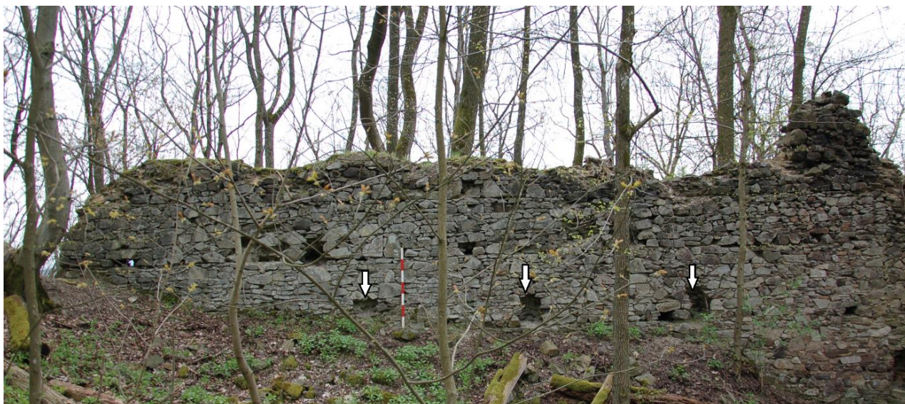
Obr. 51. Nový Herštejn. Otvory vylámané do jižní části východní obvodové hradby (označeno šipkami) pro osazení stropních trámů objektu, který zřejmě nebyl nikdy postaven. Pohled od jižní stěny donjonu k východu. Lat' 1.4 m (foto 30. 1. 2016 a úprava autor).
