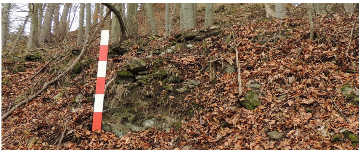
Obr. 148. Pajrek. Relikt zdiva třetí fortifikační linie na vystupujícím skalním suku. Lat' 1.4 m (foto autor 2. 1. 2016).
