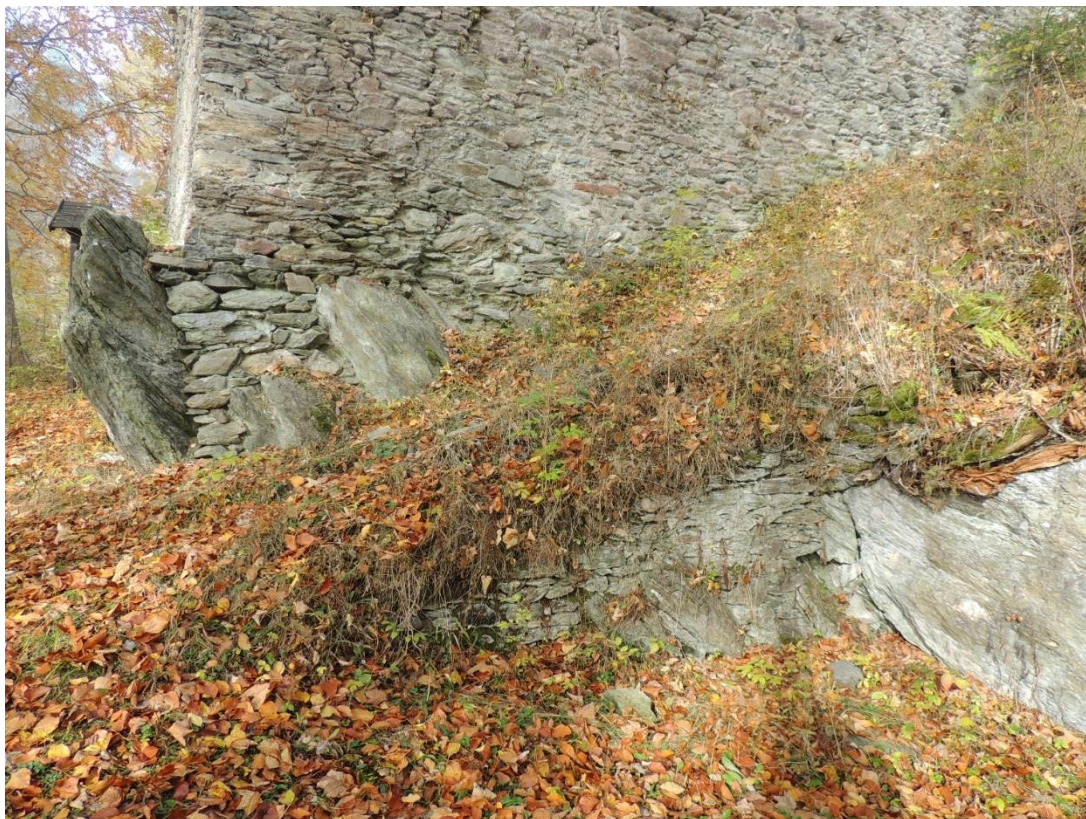
Obr. 125. Pajrek. Detail usazení základového zdiva donjonu v jihovýchodním nároží (foto autor 19. 3. 2016).
