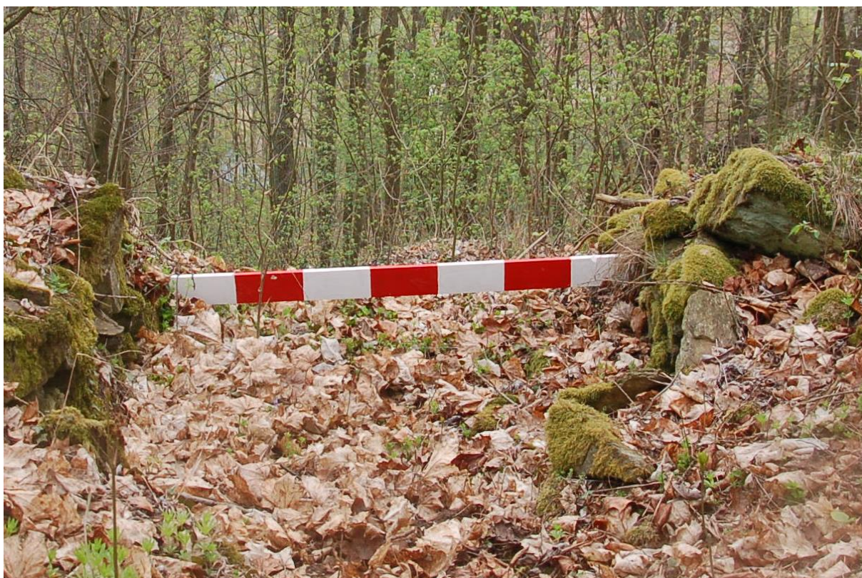
Obr. 167. Pušperk. Relikty zdi tzv. výpadové branky. Pohled z jádra hradu. Lat' 1.4 m (foto autor 6. 4. 2016).
