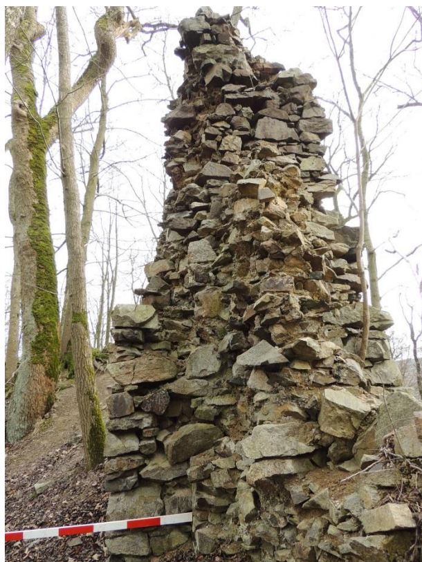
Obr. 69. Nový Herštejn. Relikt severozápadní zdi věžovitého objektu přistavěného k jižnímu zaoblenému nároží obvodové hradby. Místo připojení k jihozápadní obvodové hradbě. Jeden díl latě 0.2 m (foto autor 8. 2. 2016).
