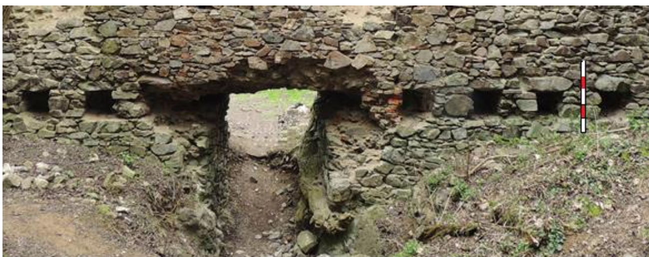
Obr. 30. Nový Herštejn. Otvory pro stropní trámy přízemí v západní stěně interiéru donjonu. Lať 1 m. (foto autor 2. 4. 2016).
