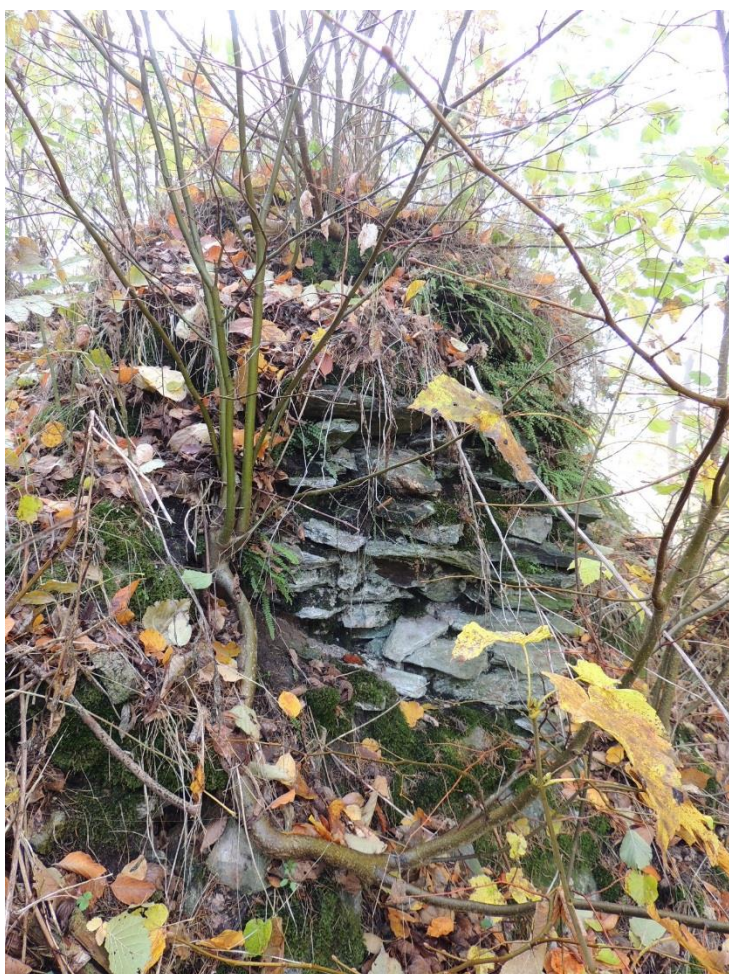
Obr. 141. Pajrek. Relikt zdi objektu na západní straně hradního jádra (foto autor 19. 3. 2016).
