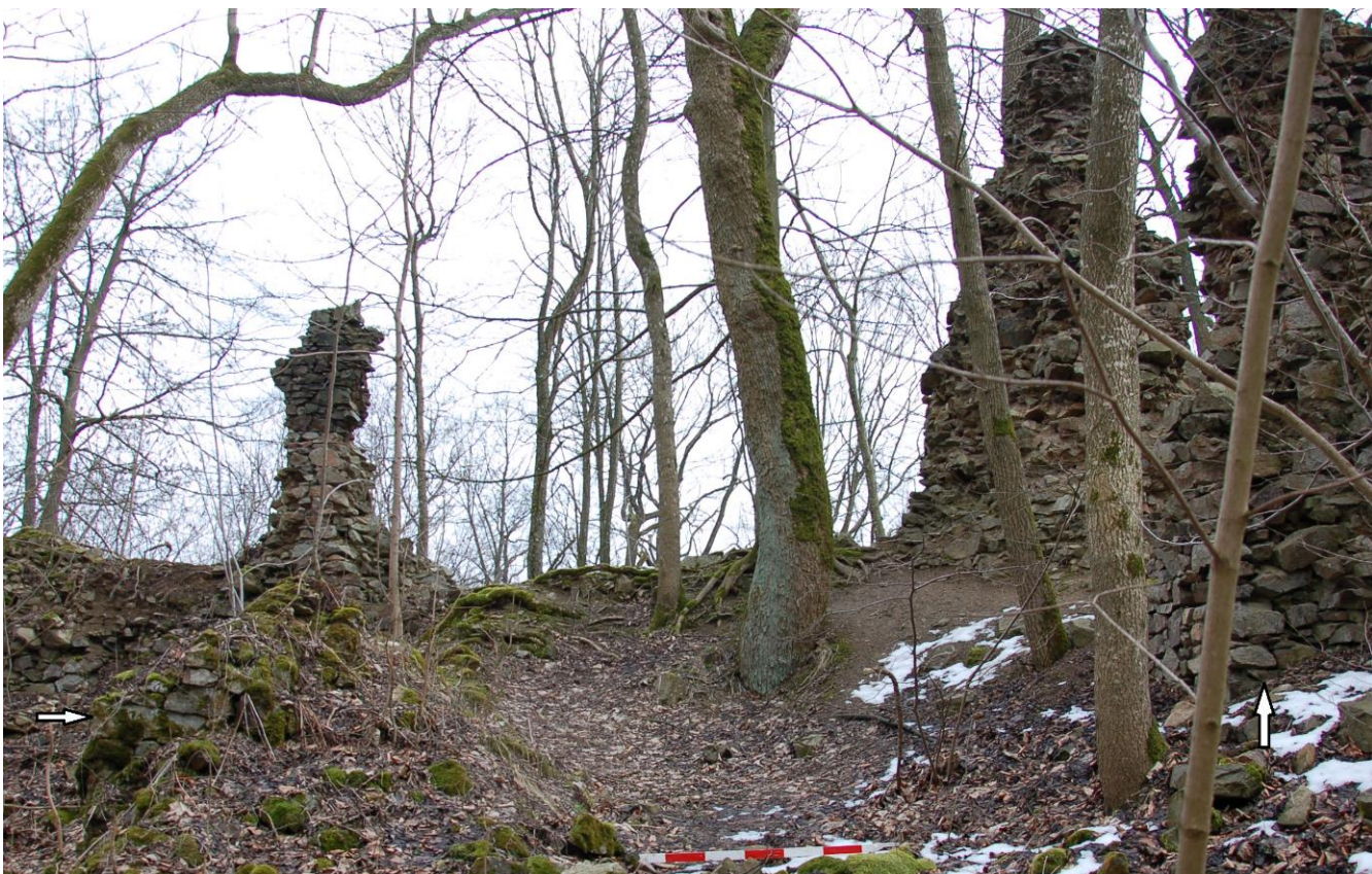
Obr. 67. Nový Herštejn. Pozůstatky věžovité stavby v jižním cípu hradu. Šipkami označeny relikty líce severozápadní nádvoří zdi. Lat' 1.4 m (foto 20. 3. 2016 a úprava autor).
