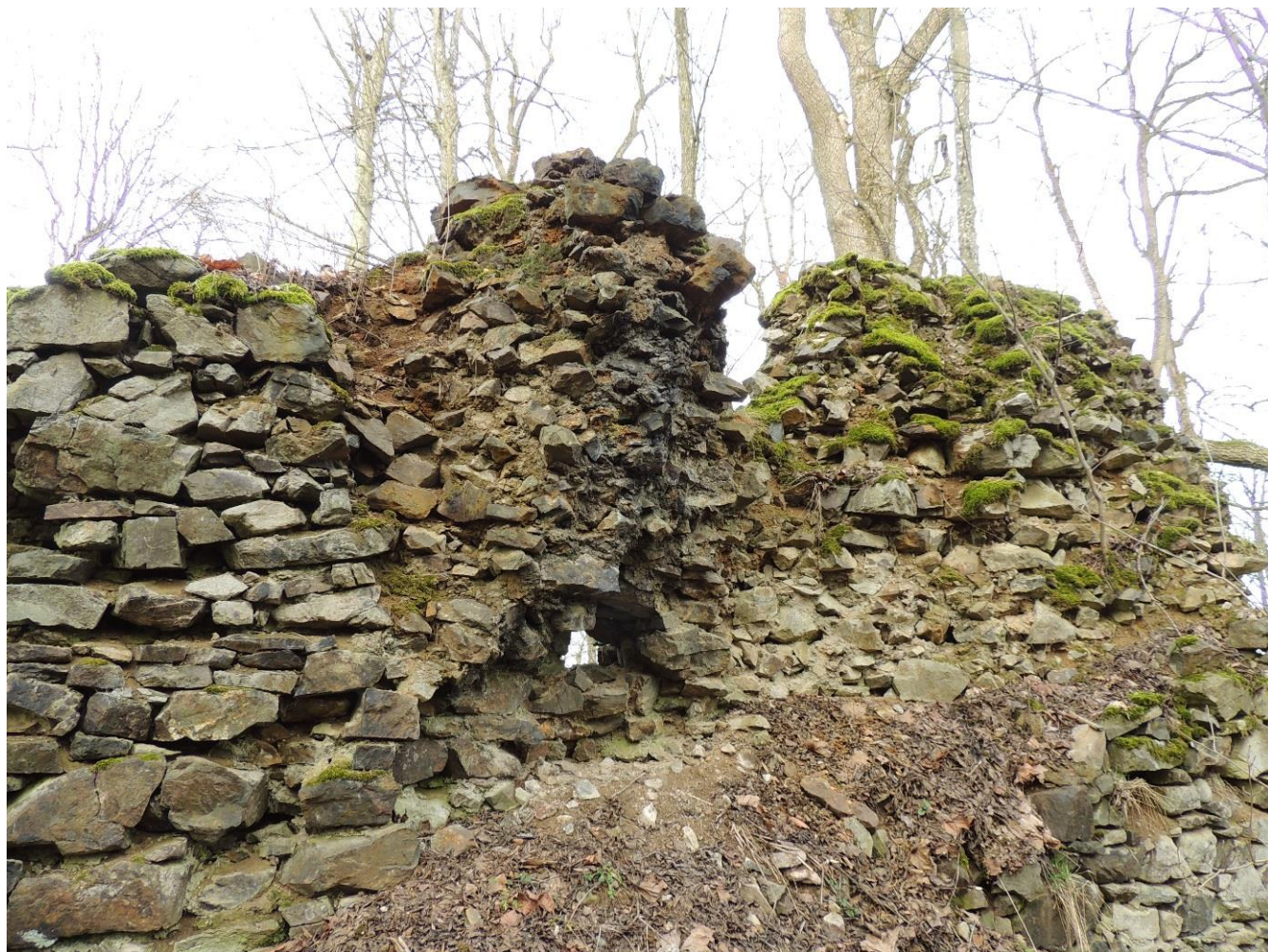
Obr. 41. Nový Herštejn. Nádvoří líc obvodové hradby se zřetelnými stavebními opravami (foto autor 8. 2. 2016).
