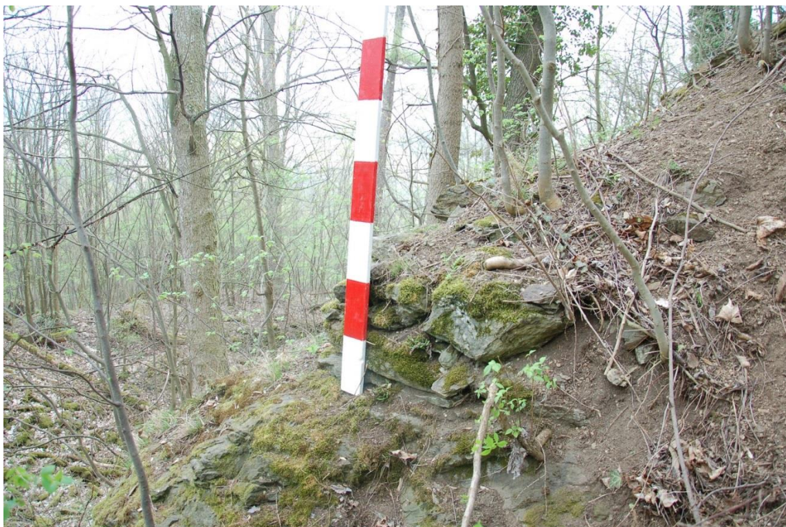
Obr. 176. Pušperk. Relikt západního nároží čtvercové bašty. Lat' 1.4 m (foto autor 6. 4. 2016)
