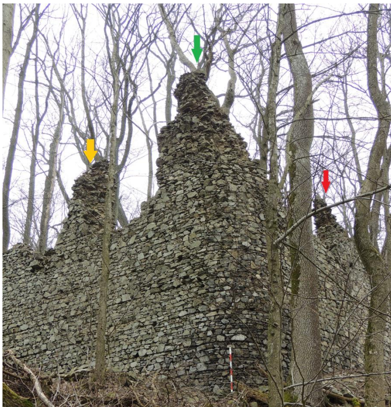
Obr. 86. Nový Herštejn. Relikty jižního věžovitého objektu. Severozápadní nároží (žlutá šipka), jižní zaoblené nároží (zelená šipka), severovýchodní nároží (červená šipka). Lať 1.4 m (foto 19. 3. 2016 a úprava autor).
