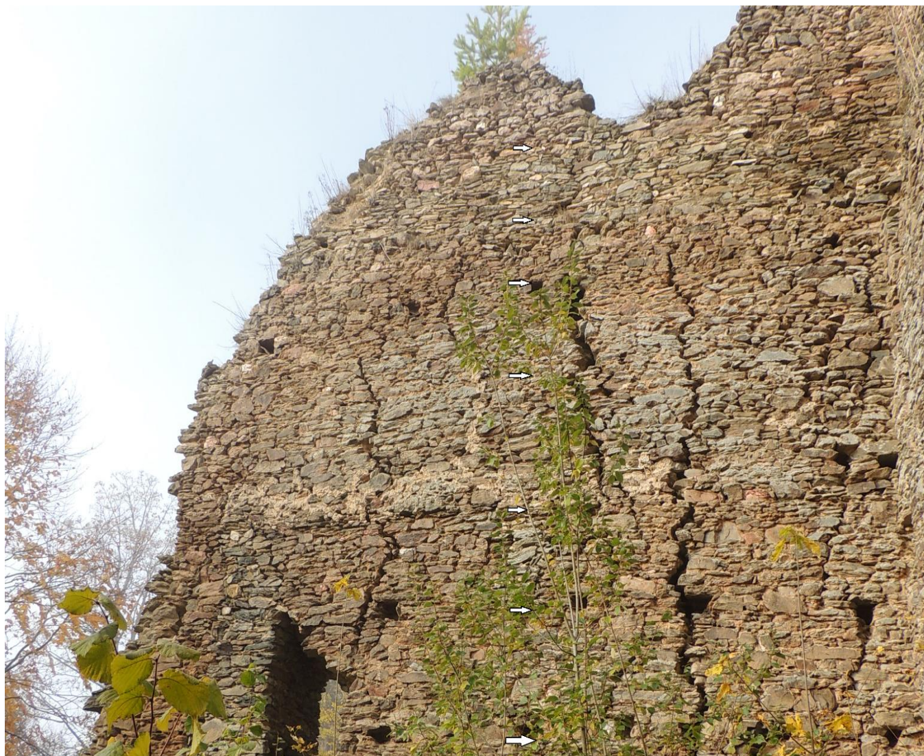
Obr. 119. Pajrek. Horizontální vyrovnávací spáry zdiva donjonu (označeno šipkou) (foto 16. 3. 2016 a úprava autor).
