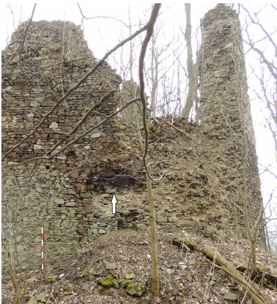
Obr. 75. Nový Herštejn. Relikt zaklenutého otvoru (označeno šipkou) v severní hradbě (foto 19. 3. 2016 a úprava autor).
