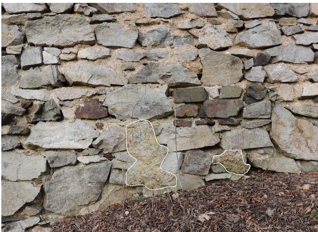
Obr. 22. Nový Herštejn. Pozůstatky původní omítky (označeno) na jižní zdi donjonu (foto 30. 1. 2016 a úprava autor).
