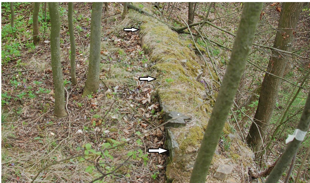
Obr. 166. Pušperk. Západní část obvodové hradby s viditelnou hranou předprsni zdi (označeno šipkami) (foto 6. 4. 2016 a úprava autor).
