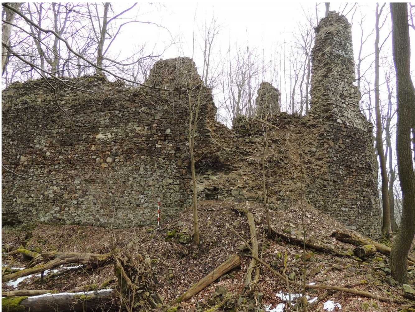
Obr. 76. Nový Herštejn. Prostor západního nároží obvodové hradby zasypaný destrukcí s relikty hranolové věže. Lat' 1.4 m (foto 19. 3. 2016 autor).
