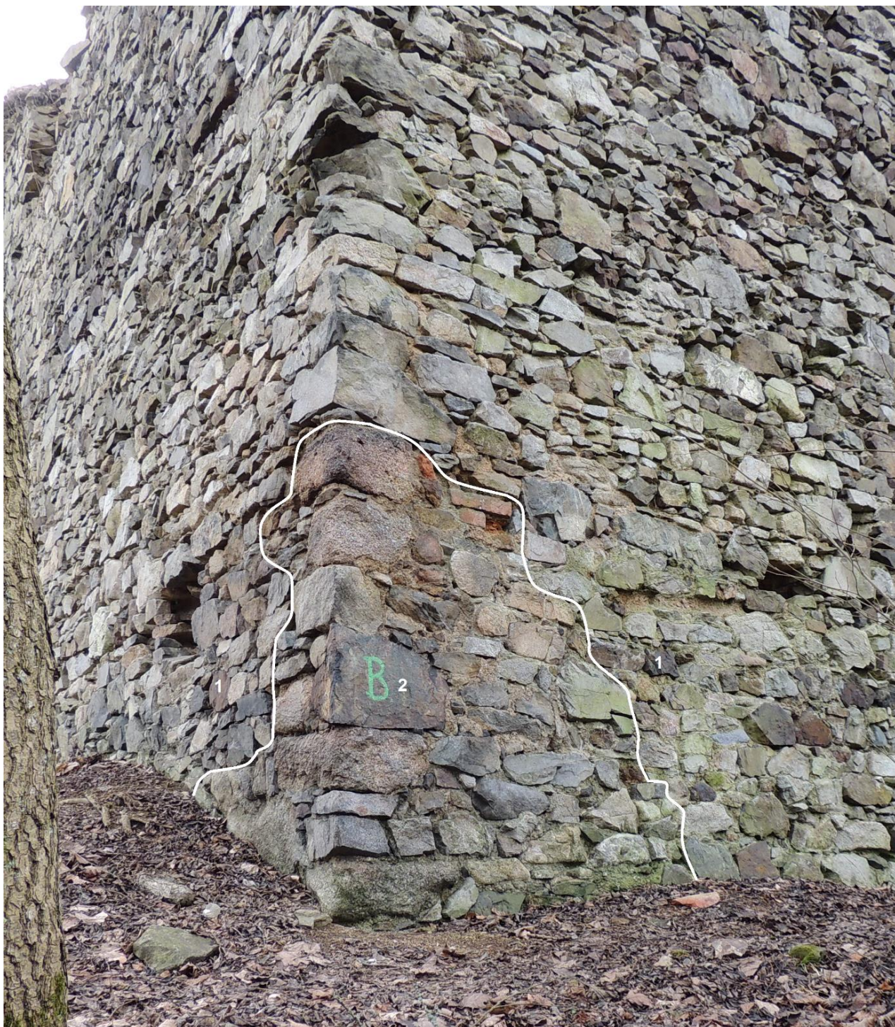
Obr. 42. Nový Herštejn. Oprava severovýchodního nároží donjonu. (1). zdivo z druhé poloviny 14. století. (2). zdivo z konce 15. století (foto 8. 2. 2016 a úprava autor).
