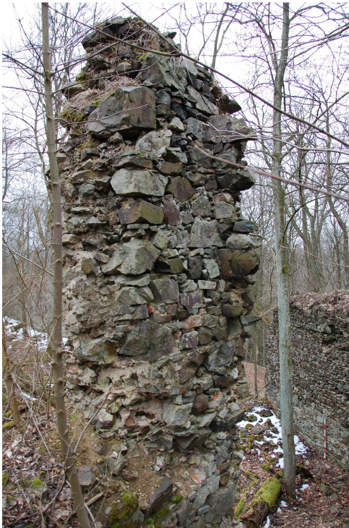
Obr. 59. Nový Herštejn. Jihovýchodní roh interiéru v úrovni druhého patra čtverhranné věže vestavěné do západního cípu obvodové hradby (foto autor 20. 3. 2016).
