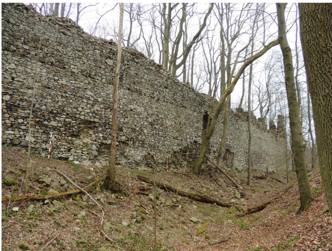
Obr. 79. Nový Herštejn. Jihozápadní úsek obvodové hradby od západního zalomení hradby. Lať 1.4 m (foto autor 19. 3. 2016).
