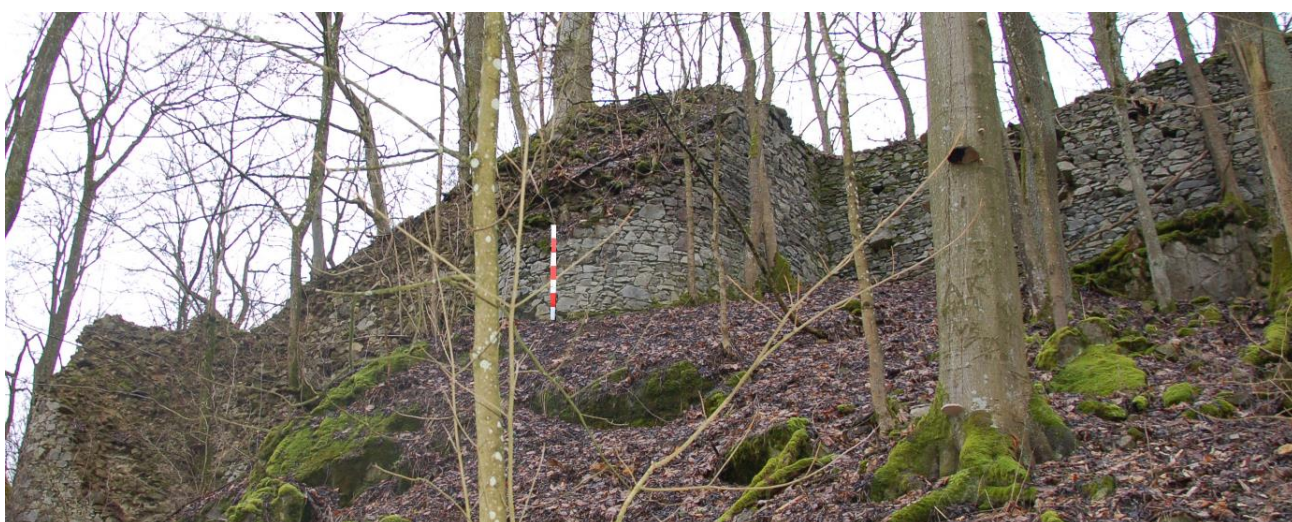
Obr. 91. Nový Herštejn. Původní obloukovitě zakončená bašta, která byla součástí východní obvodové hradby před výstavbou objektu s tzv. Panenskou věží. Pohled od severovýchodu. Lať 1.4 m (foto autor 31. 1. 2016).
