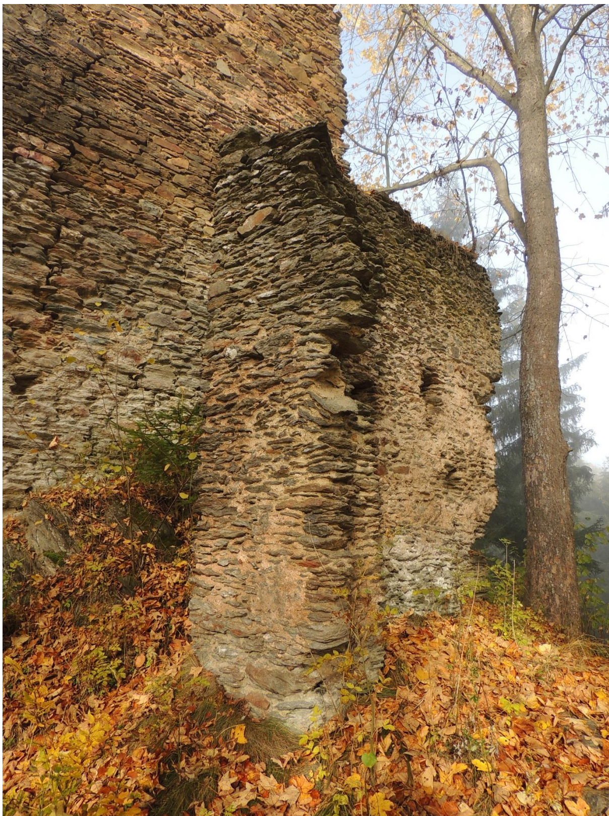
Obr. 133. Pajrek. Pozůstatky menší věžovité budovy na východní straně hradního jádra (foto autor 24. 10. 2015).
