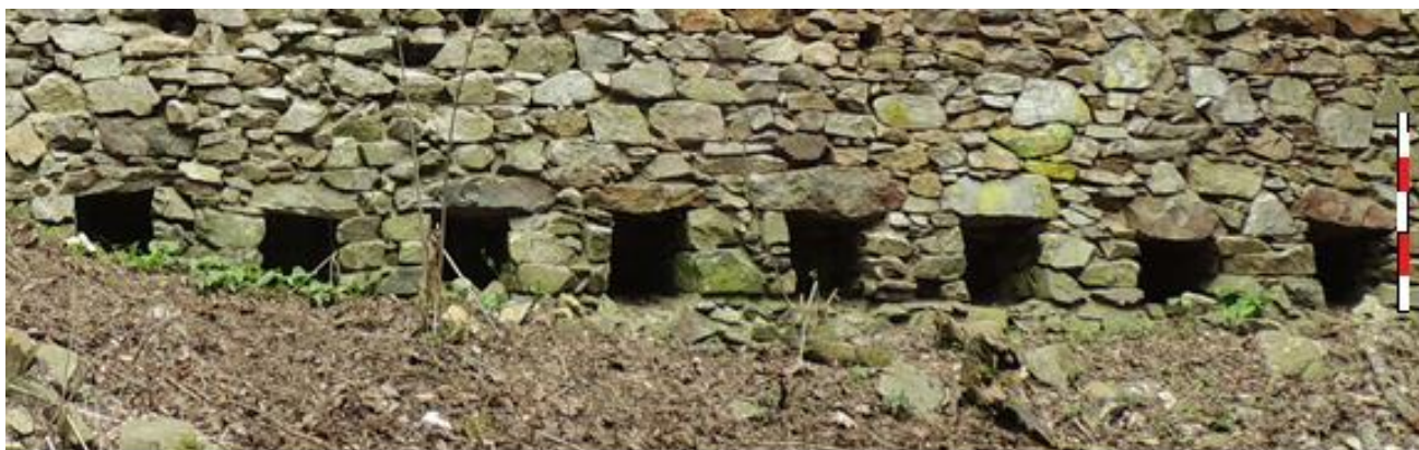
Obr. 29. Nový Herštejn. Otvory pro stropní trámy přízemí ve východní stěně interiéru donjonu. Lať 1 m. (foto autor 2. 4. 2016).
