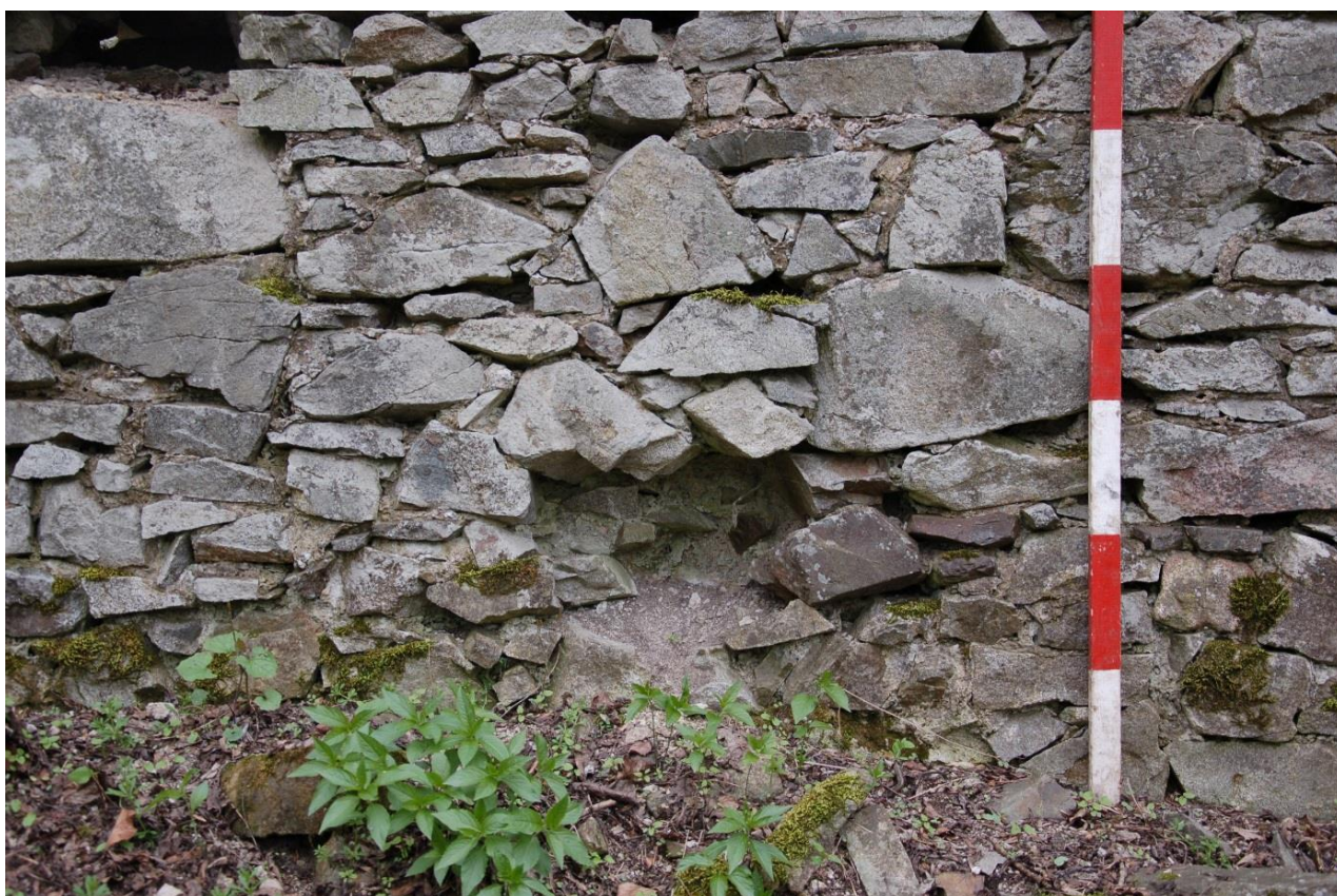
Obr. 52. Nový Herštejn. Nedokončený otvor pro uložení trámu v jižní části východní obvodové hradby. Lat' 1.4 m (foto 30. 1. 2016 a úprava autor).
