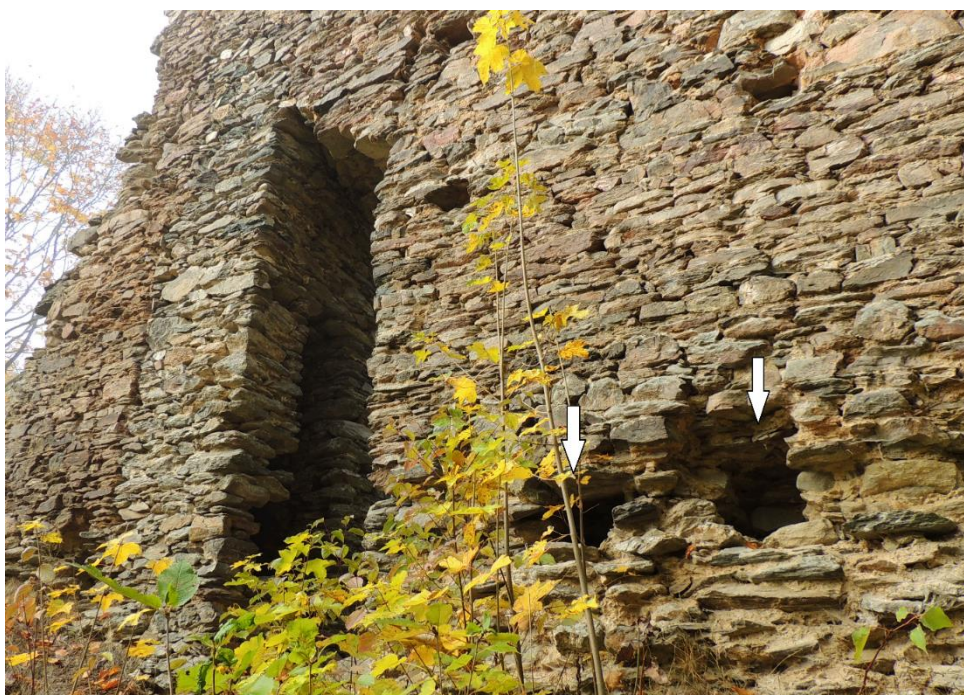
Obr. 131. Pajrek. Otvory po stropních trámech prvního podlaží (označeno šipkou) (foto 24. 10. 2015 a úprava autor).
