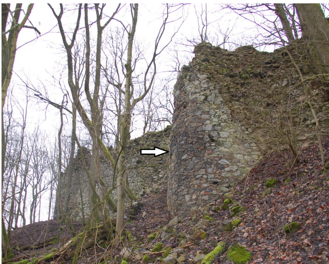
Obr. 46. Nový Herštejn. Půlkruhová věžice, tzv. Panenská věž (označeno šipkou), která se nachází v jihovýchodním nároží objektu předsunutého před čelo východní obvodové hradby. Pohled z přístupové cesty od severovýchodu (foto 30. 1. 2016 a úprava autor).
