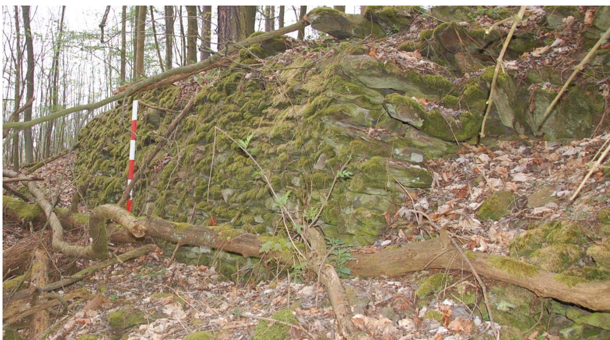
Obr. 169. Pušperk. Vnější líc východního valového tělesa obloženého na sucho kladenou plentou. Pohled od severovýchodu. Lať 1.4 m (foto autor 6. 4. 2016).
