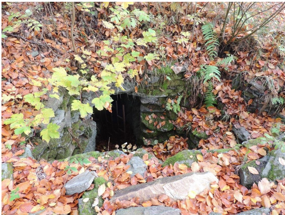
Obr. 143. Pajrek. Vstup do podzemní chodby na jižní straně donjonu (foto autor 24. 10. 2016).
