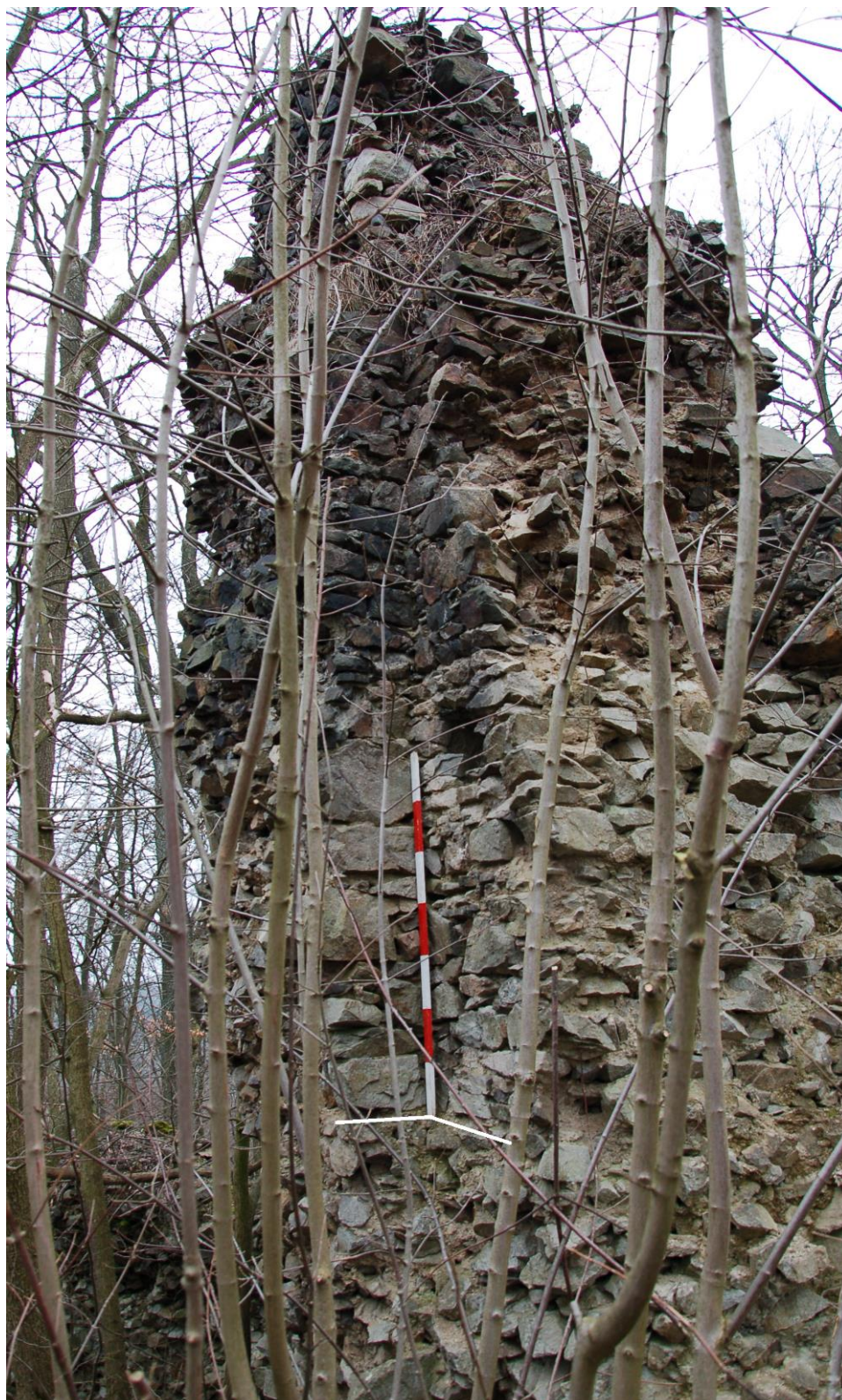
Obr. 58. Nový Herštejn. Jihozápadní roh interiéru v úrovni druhého patra čtverhranné věže postavené v západním cípu obvodové hradby. Čárou vyznačena viditelná úroveň odsazení zdi interiéru (foto 20. 3. 2016 a úprava autor).
