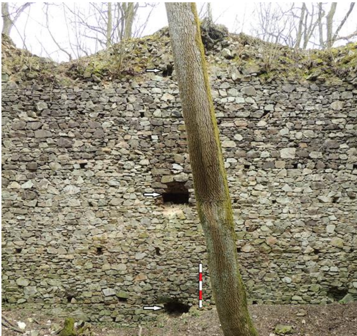
Obr. 31. Nový Herštejn. Otvory pro osazení průvlaků prvního, druhého a třetího patra (označeno šipkami) v jižní stěně interiéru donjonu. Lat' 1 m. (foto autor 2. 4. 2016).
