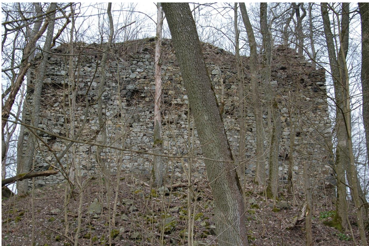
Obr. 21. Nový Herštejn. Vnější líc jižní zdi donjonu (foto 30. 1. 2016 autor).
