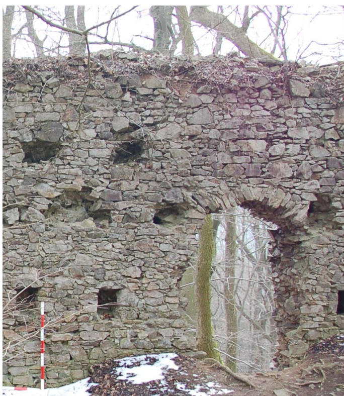
Obr. 65. Nový Herštejn. Tzv. výpadová branka v jihozápadní obvodové hradbě. Pohled na nádvoří stranu. Lať 1.4 m (foto autor 8. 2. 2016).
