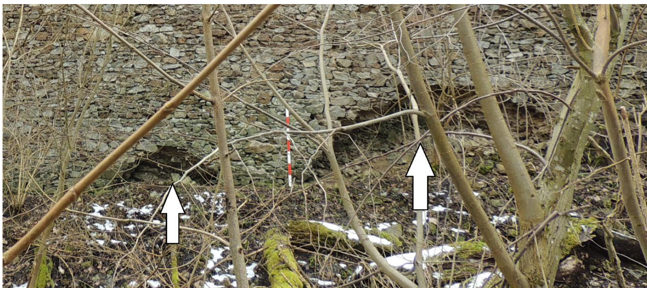
Obr. 74. Nový Herštejn. Kaverny u paty severní obvodové hradby, jejichž vznik je přikládán k dobývání hradu Bavyry v třetí čtvrtině 15. století (foto 19. 3. 2016 a úprava autor).
