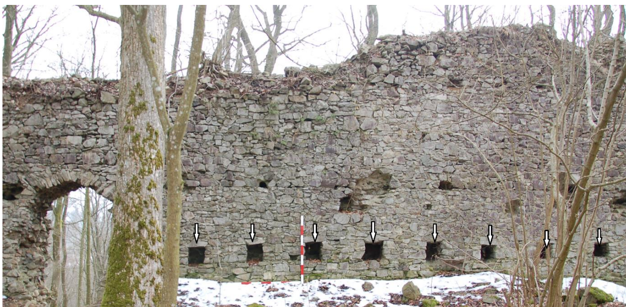
Obr. 40. Nový Herštejn. Jihozápadní úsek obvodové hradby s předpřipravenými otvory (označeno šipkami) pro osazení stropních trámů objektu přistavěného k této hradbě v průběhu 14. století. Lať 1.4 m (foto 20. 3. 2016 a úprava autor).
