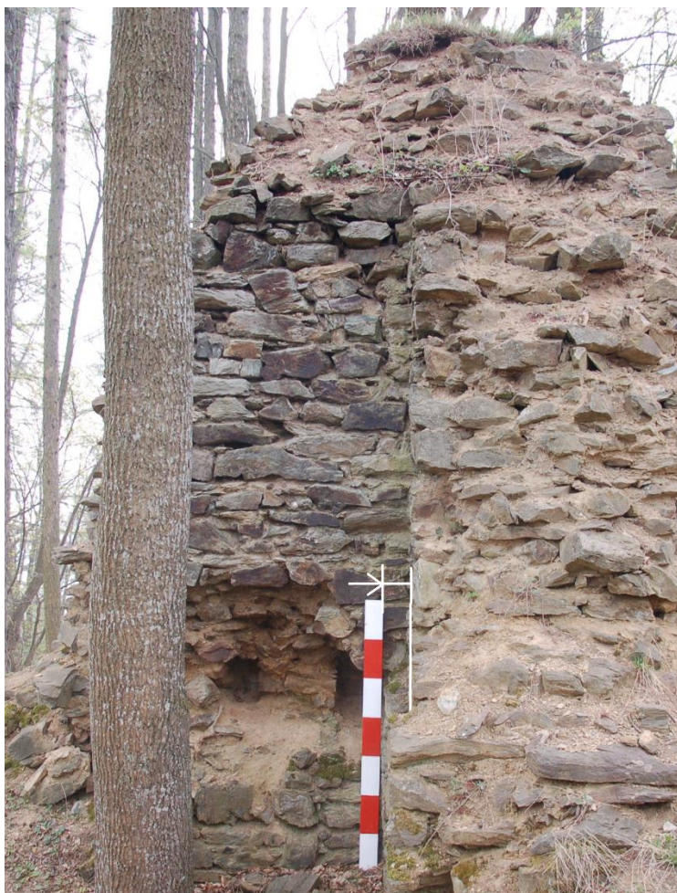
Obr. 162. Odsazení obvodové zdi v úrovni prvního podlaží v interiéru donjonu. Lat' 1.4 m (foto 6. 4. 2016 a úprava autor).
