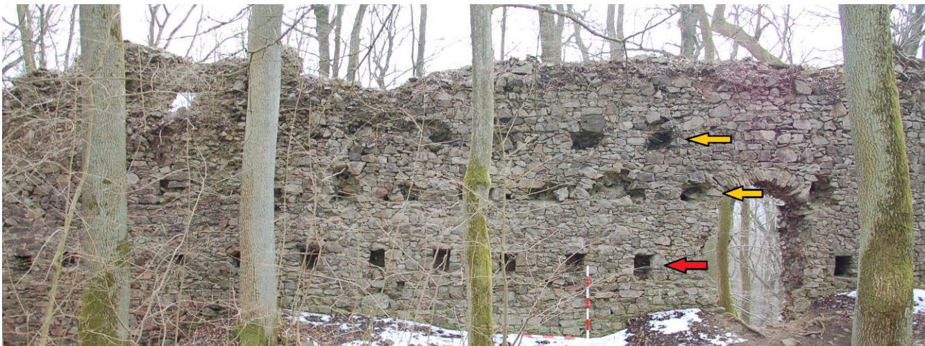
Obr. 66. Nový Herštejn. Tři řady otvorů v jihozápadní obvodové hradbě. Řada označená červenou šipkou pochází z období výstavby obvodové hradby (pol. 14. stol.). Řady otvorů označené žlutou šipkou byly vylámany do hradby dodatečně pravděpodobně koncem 15. stol. (foto 20. 3. 2016 a úprava autor).
