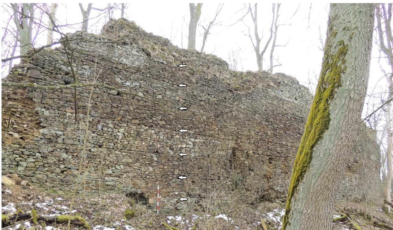
Obr. 73. Nový Herštejn. Vnější strana severní obvodové hradby od prostoru hradní brány směrem k západu. Šipkami vyznačeny stavební vyrovnávací spáry. Lat' 1.4 m. (foto autor 19. 3. 2016).
