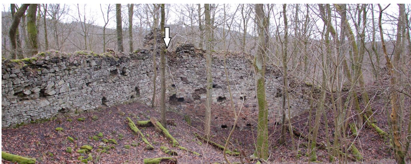
Obr. 71. Nový Herštejn. Jihovýchodní a východní část obvodové hradby. Šipkou označeno zalomení hradby (foto 30. 1 2016 a úprava autor).
