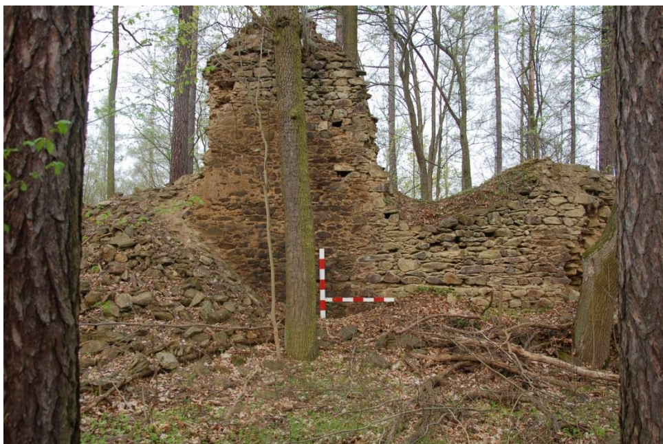
Obr. 160. Pušperk. Relikt jihovýchodní zdi původního donjonu. Lat' 1.4 m (foto autor 6. 4. 2016).
