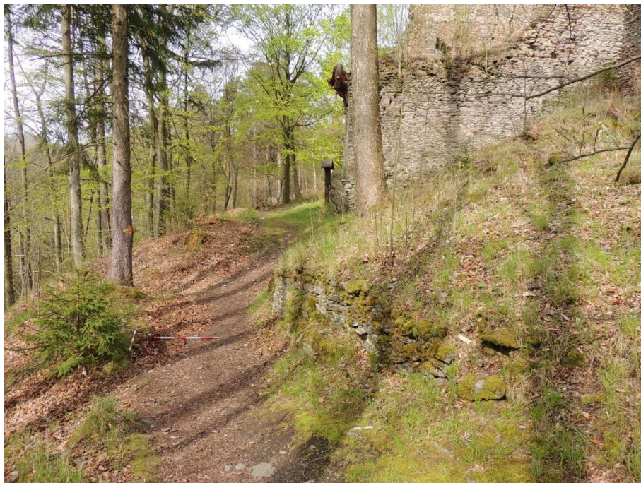
Obr. 140. Pajrek. Prostor přístupové cesty u východního příkopu. Lat' 1 m (foto autor 22. 4. 2016).
