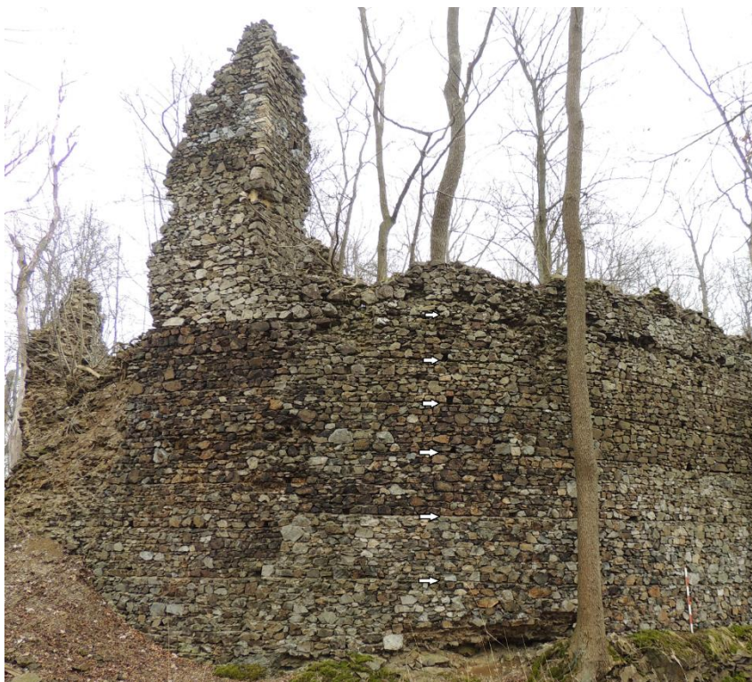
Obr. 78. Nový Herštejn. Vnější strana západní části obvodové hradby od prostoru hranolové směrem k jihu. Šipkami vyznačeny stavební vyrovnávací spáry. Lať 1.4 m. (foto autor 19. 3. 2016).
