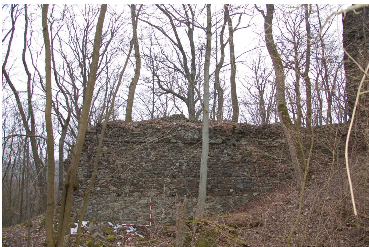
Obr. 61. Nový Herštejn. Úsek obvodové hradby jižně od hranolové věže (vpravo). Pohled na nádvoří stranu. Lat' 1.4 m (foto autor 20. 3. 2016).
