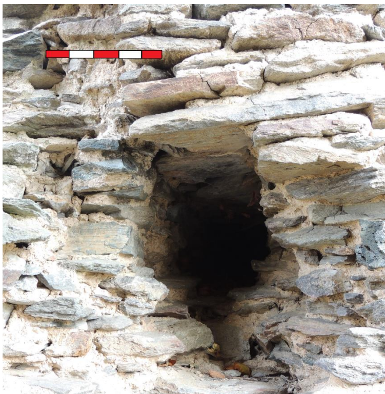
Obr. 129. Pajrek. Otvor v síle zdiva pro zasunutí dveřní závory v místě původního vstupu. Jeden dílek měřítka 5 cm. (foto 24. 10. 2015 a úprava autor).
