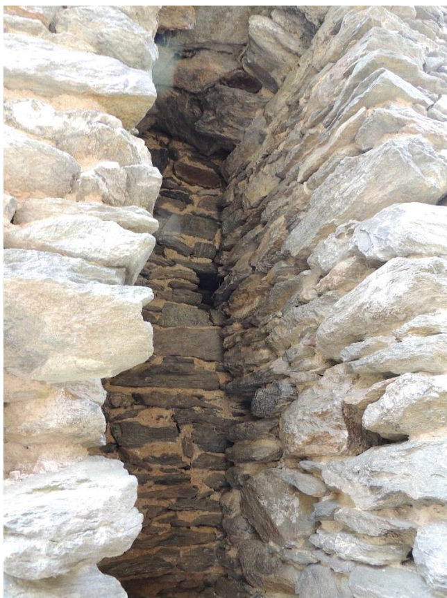
Obr. 128. Pajrek. Prostor v síle zdi novověké zazdívky původního vstupu do donjonu (foto autor 24. 10. 201ř).
