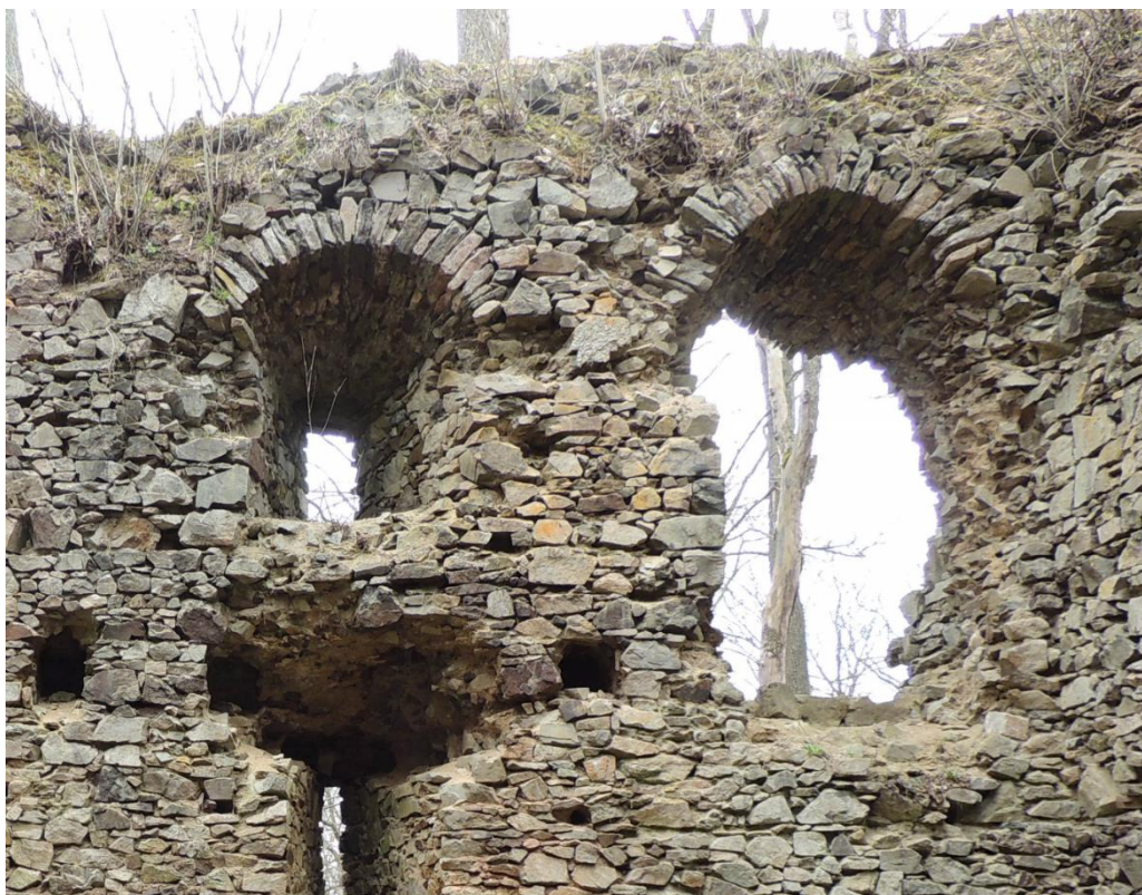
Obr. 25. Nový Herštejn. Původní vstupní otvor do donjonu v západní stěně v úrovni druhého patra. Pohled z interiéru (foto 2. 4. 2016 autor).
