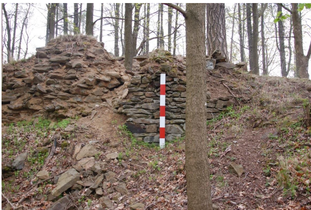
Obr. 163. Pušperk. Relikt nádvoří zdi v jádře hradu. Lat' 1.4 m (foto autor 6. 4. 2016).
