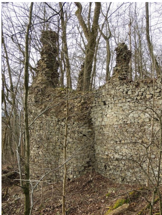
Obr. 82. Nový Herštejn. Napojení zesíleného jižního nároží k jihovýchodnímu úseku obvodové hradby (foto autor 8. 2. 2016).
