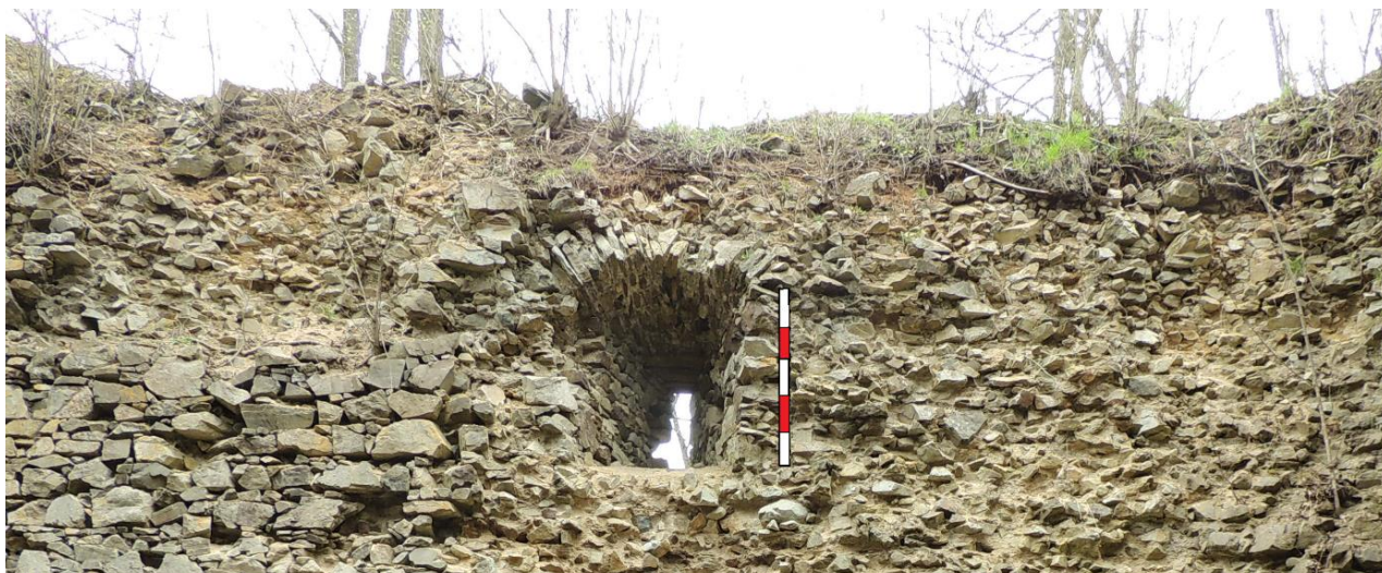
Obr. 35. Nový Herštejn. Šterbinový otvor v severní zdi druhého patra interiéru donjonu. Lat' 1 m (foto autor 2. 4. 2016).
