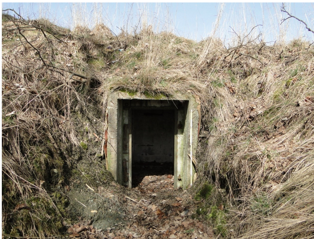
Obr. 80: Vchod do velitelského úkrytu v obci Prameny v sektoru 9. Objekt č. 240.
