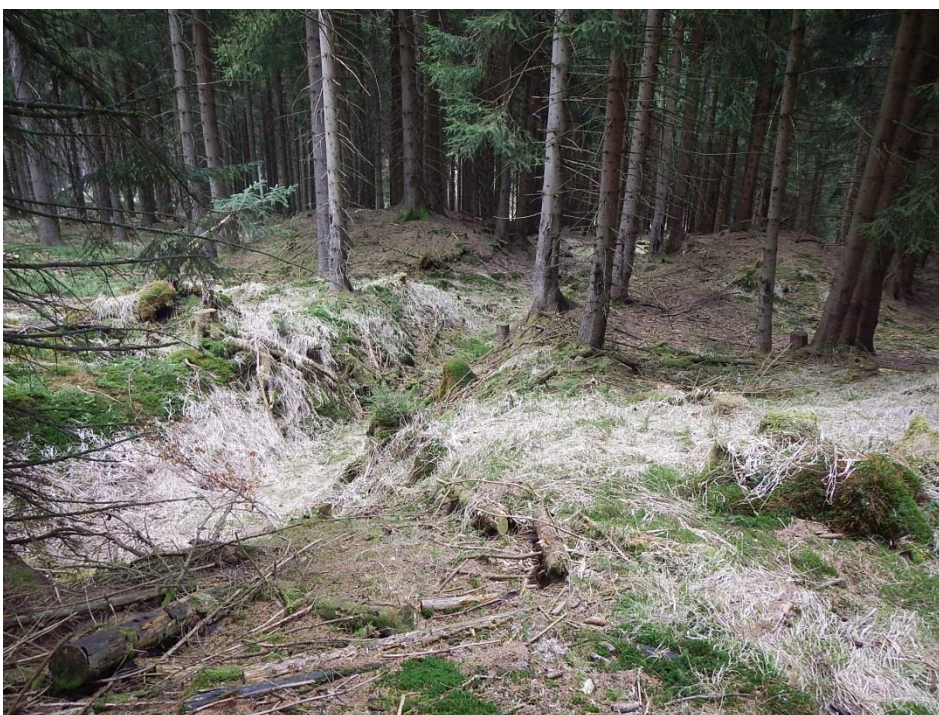
Foto č. 12: Lysina, V svah, zasuté ústí štoly č. 5 (vlevo), v pozadí patrné související odvaly
