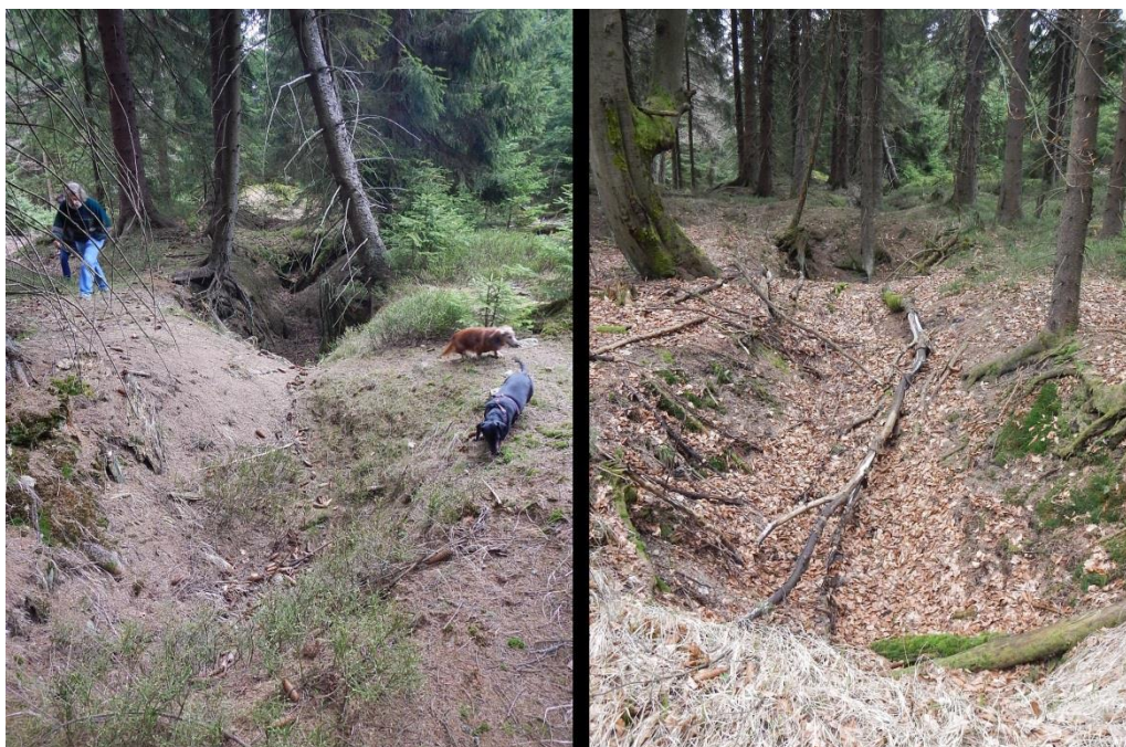
Foto č. 14: Linie propadů do podzemních prostor, indikující průběh neznámého díla; vlevo propady do prostor štoly č. 4, vpravo propady do prostor štoly č. 3
