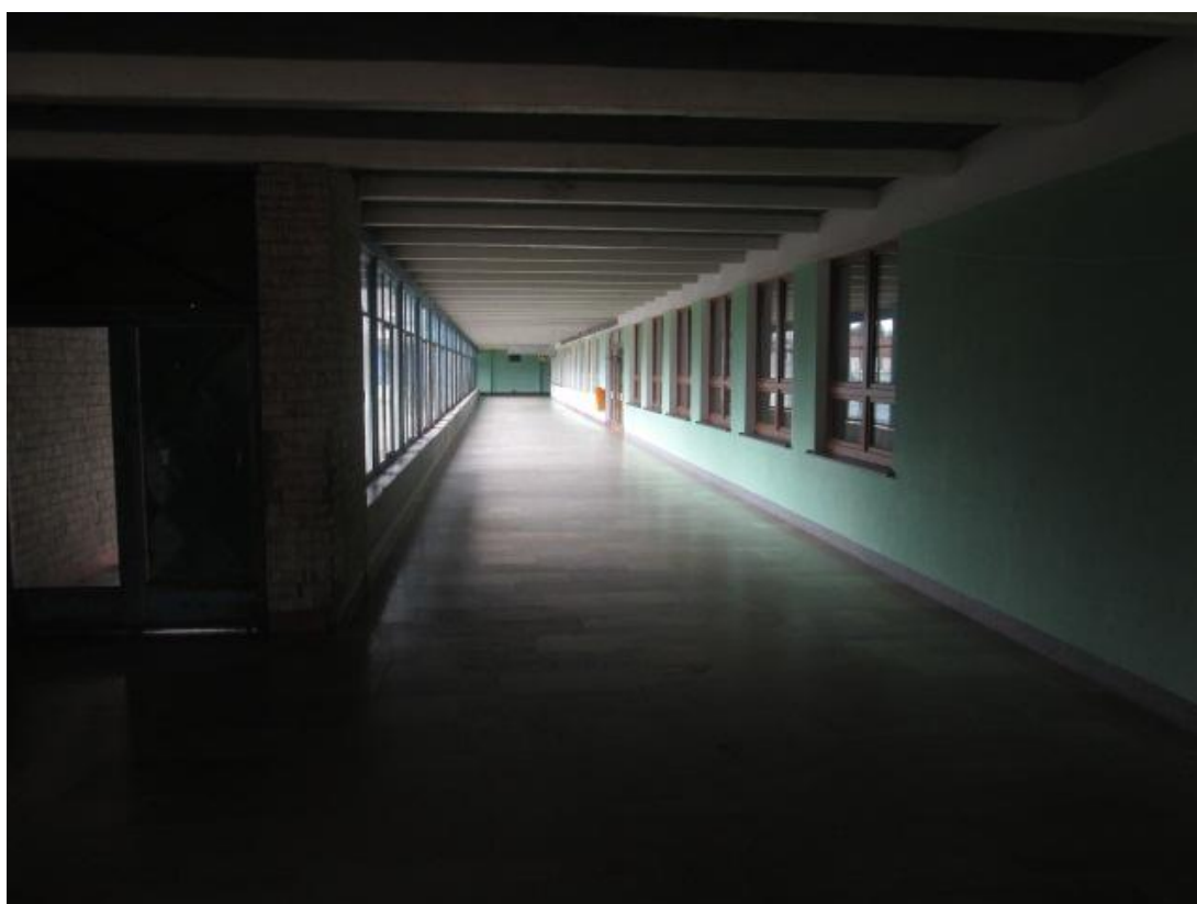
Příloha č. 9 Spojovací chodba v budově občanské vybavenosti
