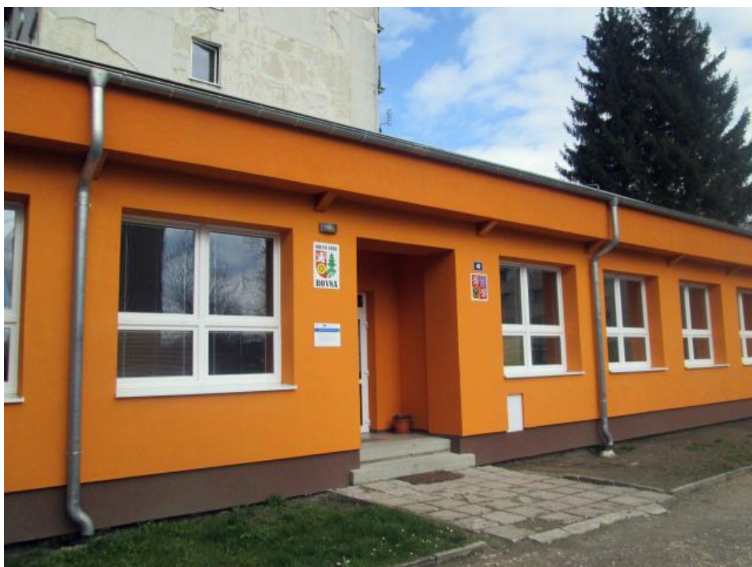
Příloha č. 10 Zrekonstruovaná budova obecního úřadu
