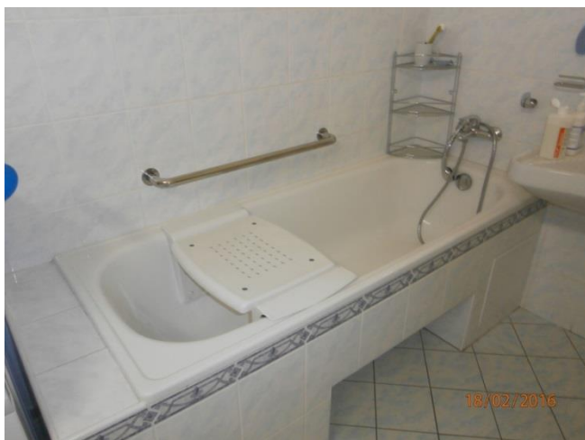
Obrázek 40: Bezbariérová úprava vany
