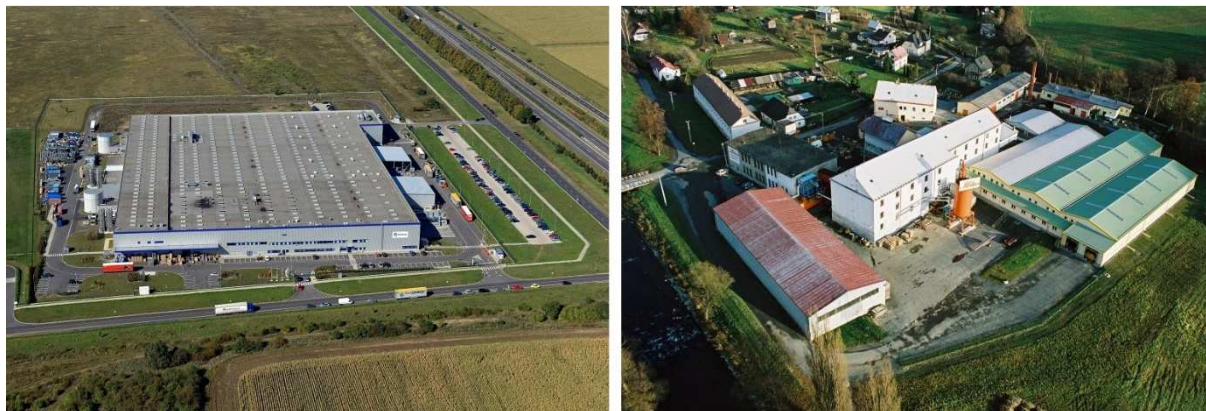
Obrázek 2-2: Struktura monobloku (vlevo) a členěné zástavby (vpravo) [20], [21]
