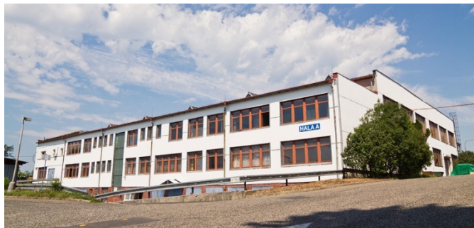
Obr.č.17 pohled na halu B [5]
