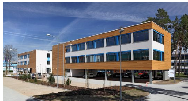
Obr.č.18 pohled na budovu B2 VTP [5]
