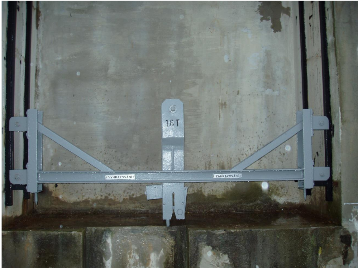
obr. 6, Stávající řešení na ČSH-HNĚVKOVICE - ukázka uskladnění traverzy
