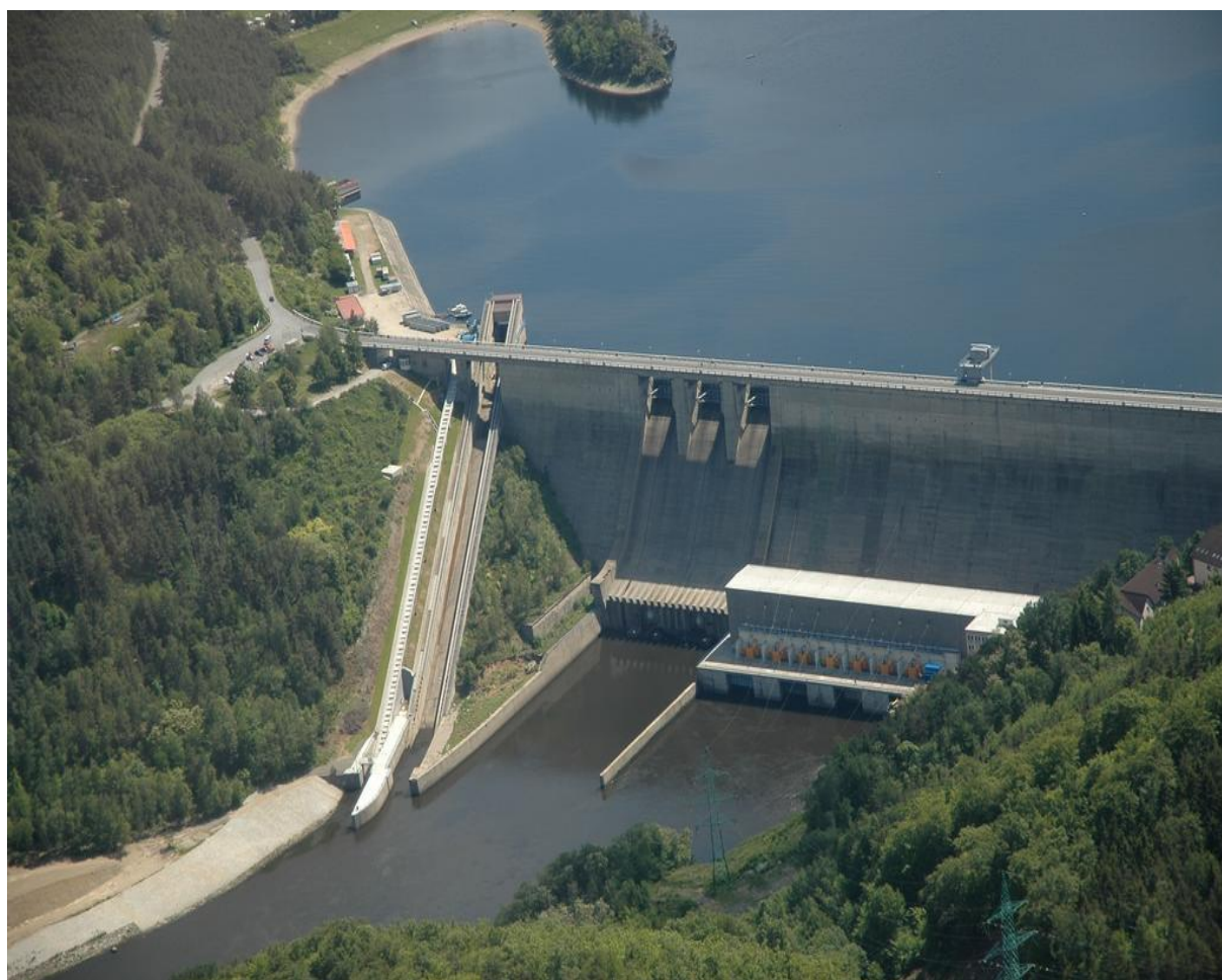
Obrázek 7 Středotlaká, akumuláční, vodní elektrárna Orlická[40]
