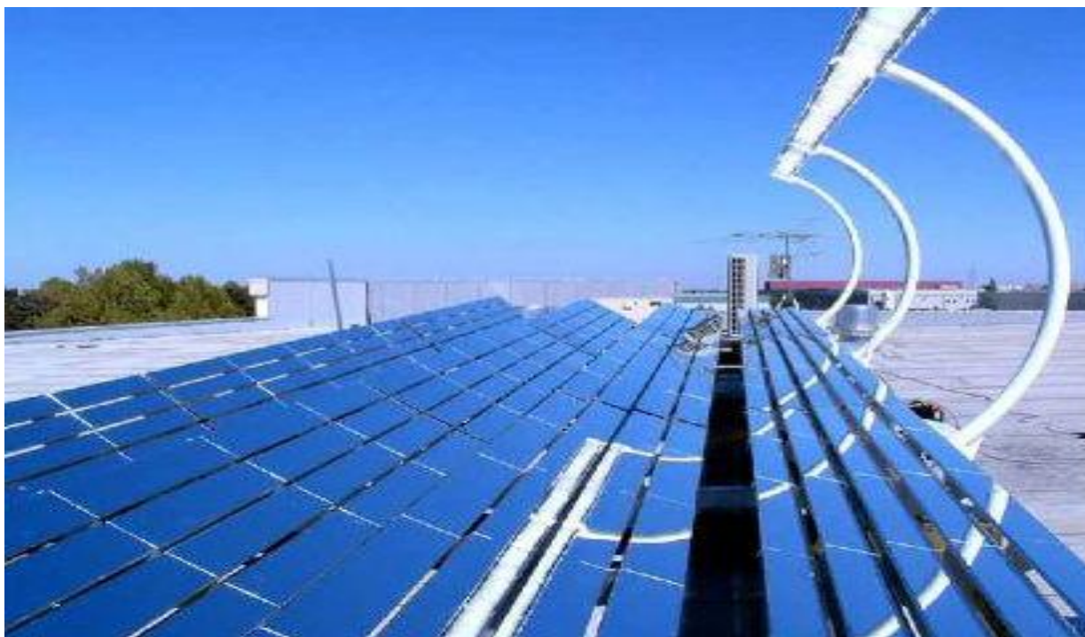
Obrázek 35 Fresnelovi koncentrující solární kolektory [30]
