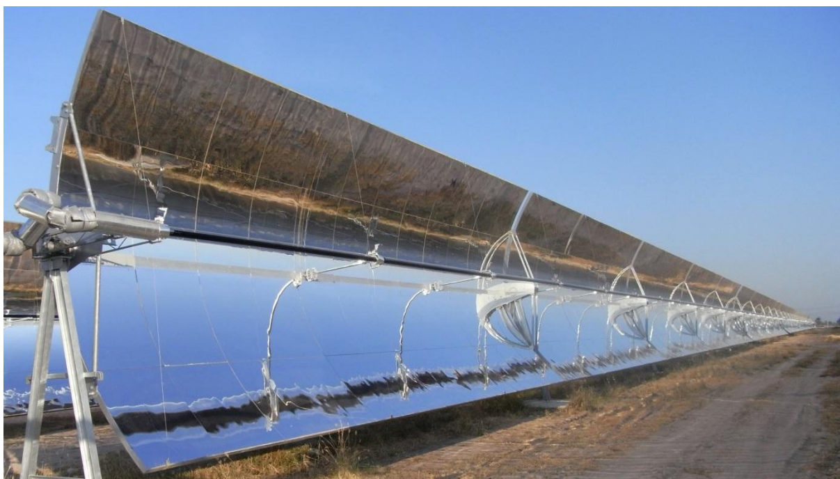
Obrázek 33 Parabolický solární koncentrující kolektor [29]
