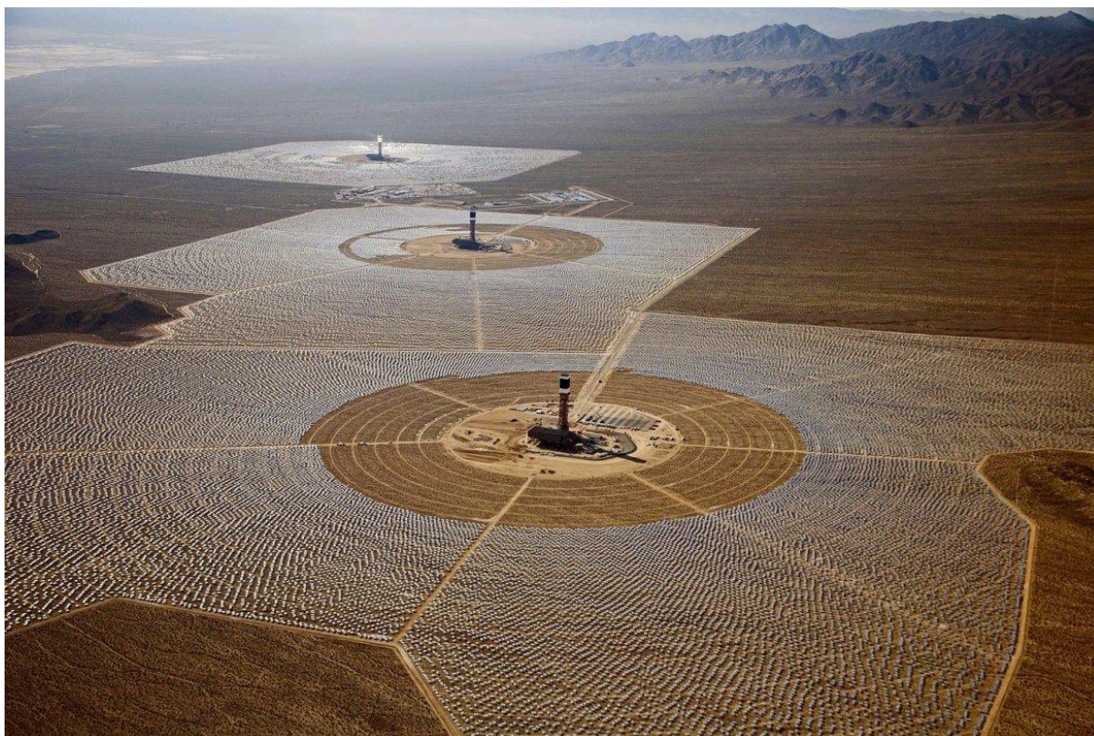
Obrázek 26 Nejvýkonnější fototermální elektrárna na světě Ivanpah [21]
