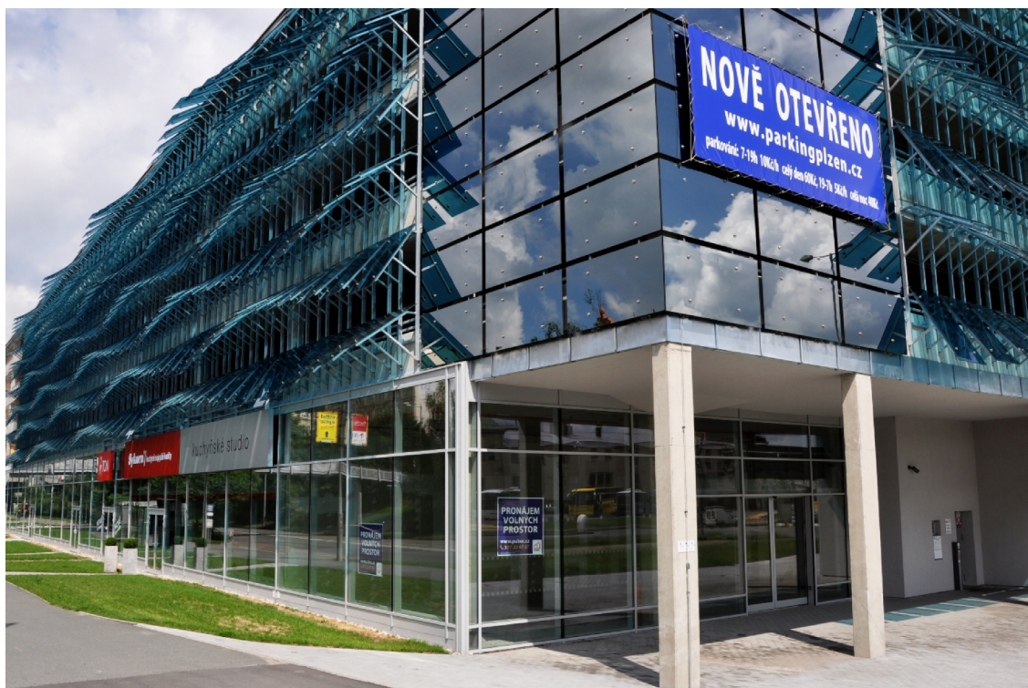
foto .5: pohled na parkovací dům z Tyršovy ulice
