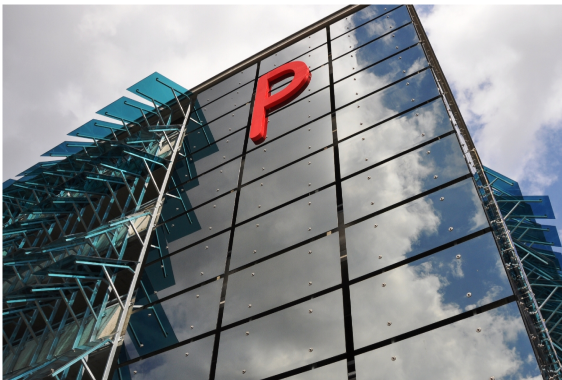
foto .8: p vodn plánované fotovoltaické panely byly nahrazeny prostým sklem
