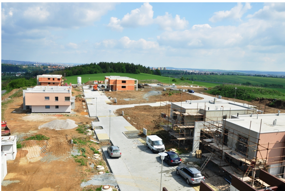
foto .12: 2011 – infrastruktura před dokončením, probíhající výstavba obytných budov
