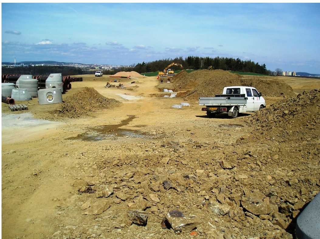
foto .10: 2009 – výstavba sítí (kanalizace, plyn, elektro, voda, VO)
