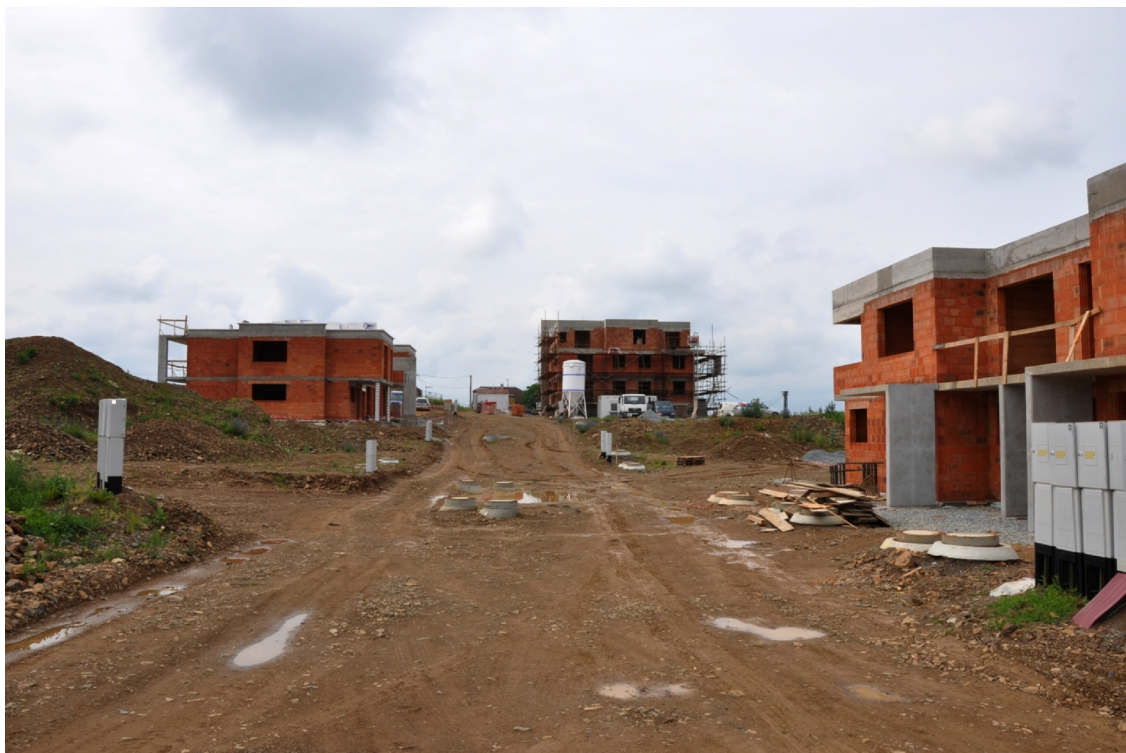
foto .11: 2010 - hrubé stavby obytných dom , upravené podloží nových komunikací
