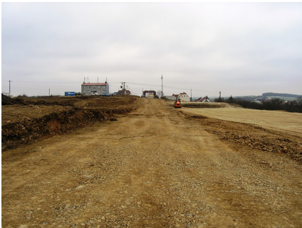
foto .9: 2009 - provádění prvotních hrubých terénních úprav
