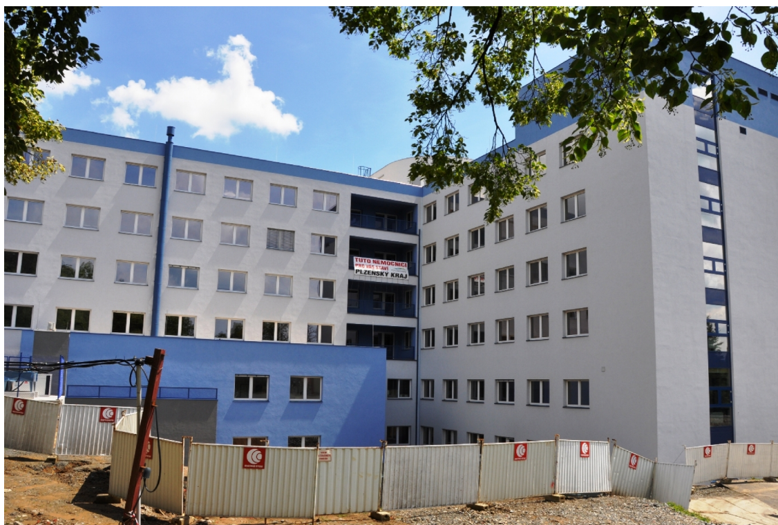
foto .3: zadní trakt novostavby – monobloku Klatovské nemocnice
