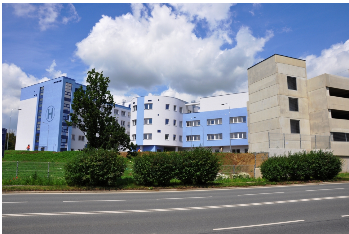
foto .2: pohled na tém dokon enou novou budovu a parkovací d m
