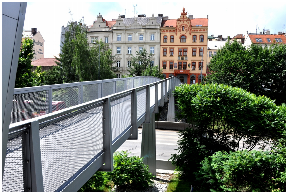
foto .6: pěší lávka, po které každý pohodlně překlene rušný průtah v Tyršově ulici
