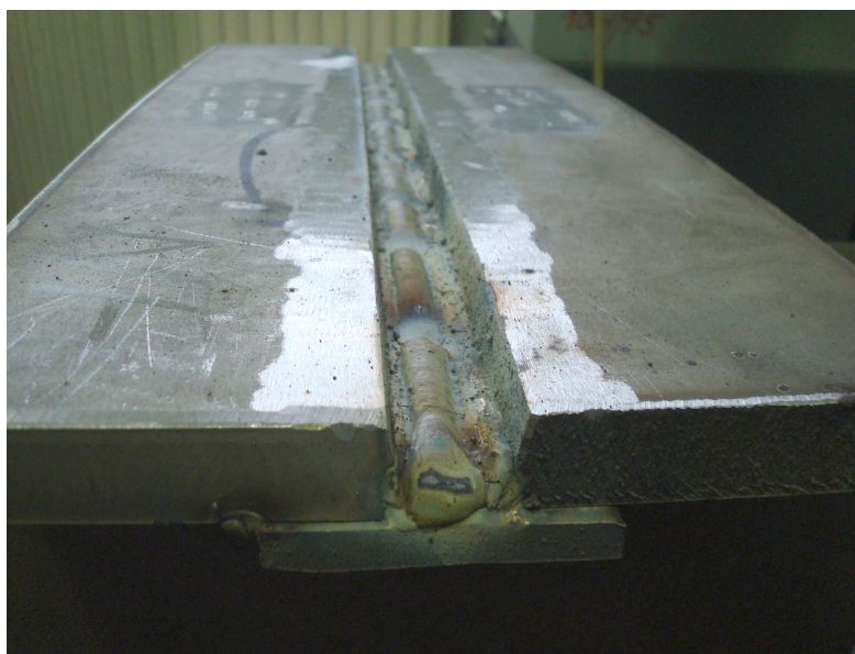
Obrázek 15. Navařená housenka před očištěním
