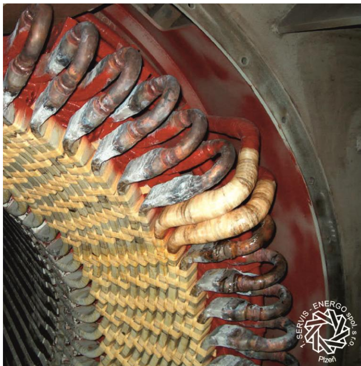
Obr. 33 Detailní pohled na propojky spodní a horní polohy, uprostřed vstup pro chlazení, Tušimice 200 MW [13]
