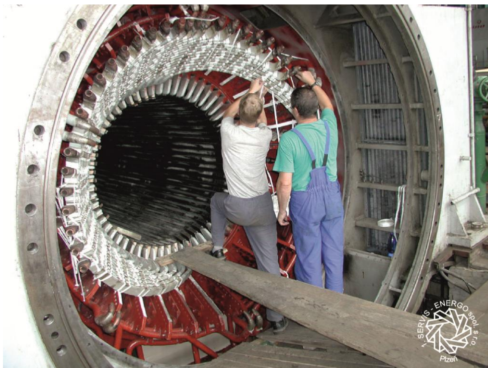
Obr. 31 Zakládání a vyvazování spodní polohy vinutí, Tušimice 200 MW [13]
