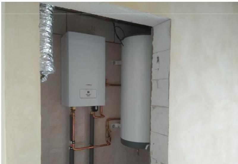
Obrázek 4.7.6: Instalace kotle a boileru
