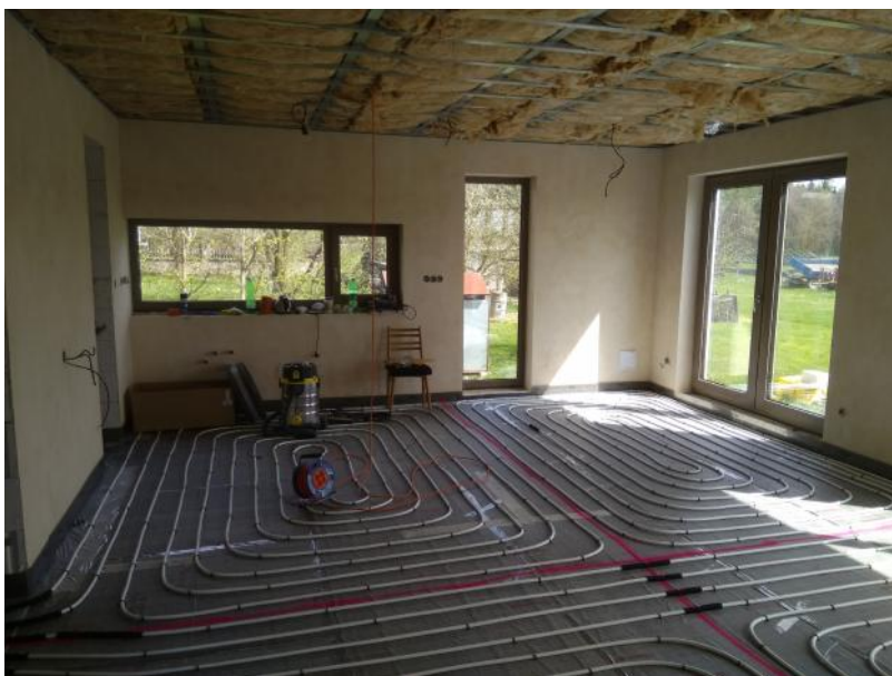
Obrázek 4.7.7: Rozložení topných hadic
