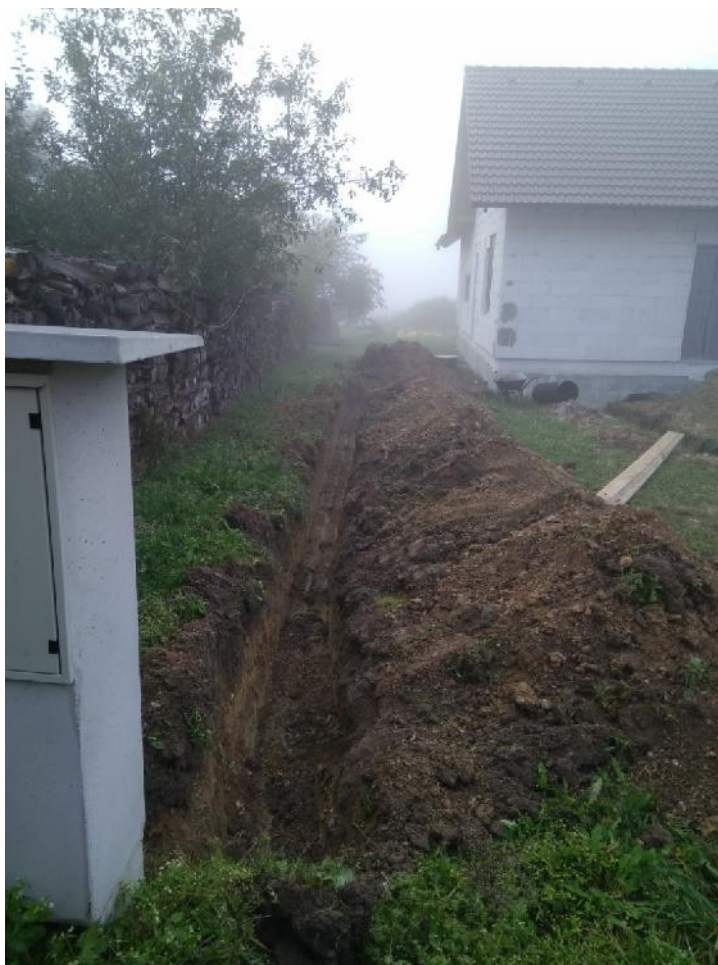
Obrázek 4.7.1: Příprava zemního výkopu
