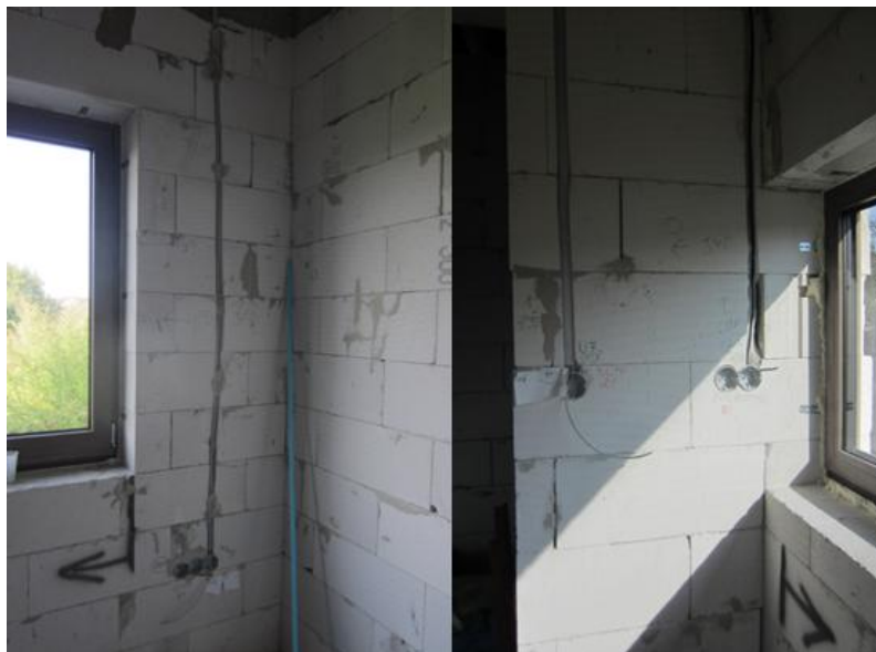
Obrázek 4.7.2: Instalace zásuvkových krabic v RD
