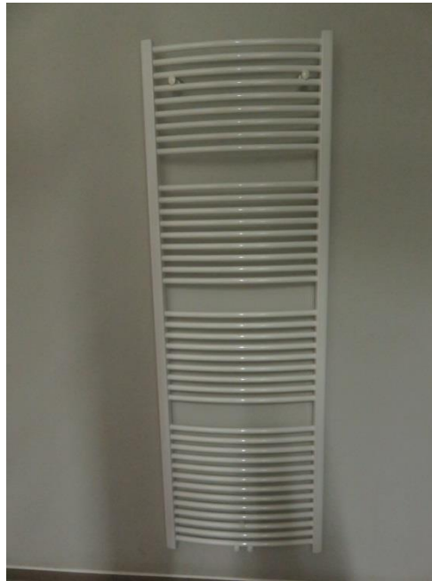
Obr. 2 Otopné těleso B50: délka 1 800 mm, šířka 600 mm
