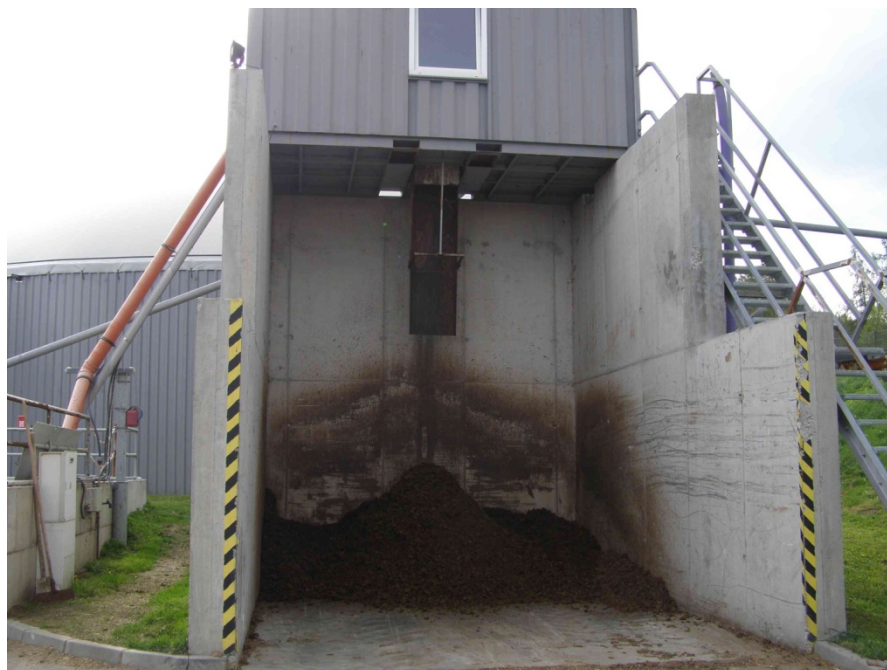
Obr. 20: Separátor digestátu a výsledný separát (foto autor)
