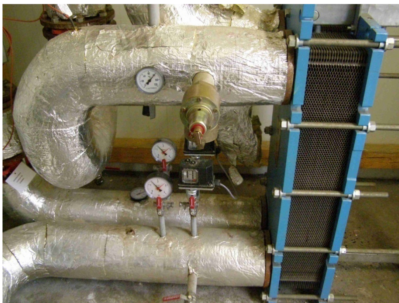
Obr. 18: Sekundární výměník tepla (foto autor)
