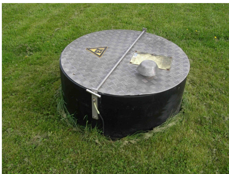
Obr. 22: Vstup do kondenzační šachty (foto autor)
