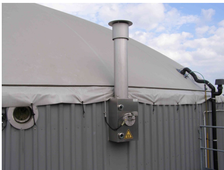
Obr. 13: Přetlaková/podtlaková pojistka (foto autor)
