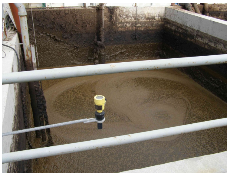
Obr. 8: Vstupní jímka (foto autor)
