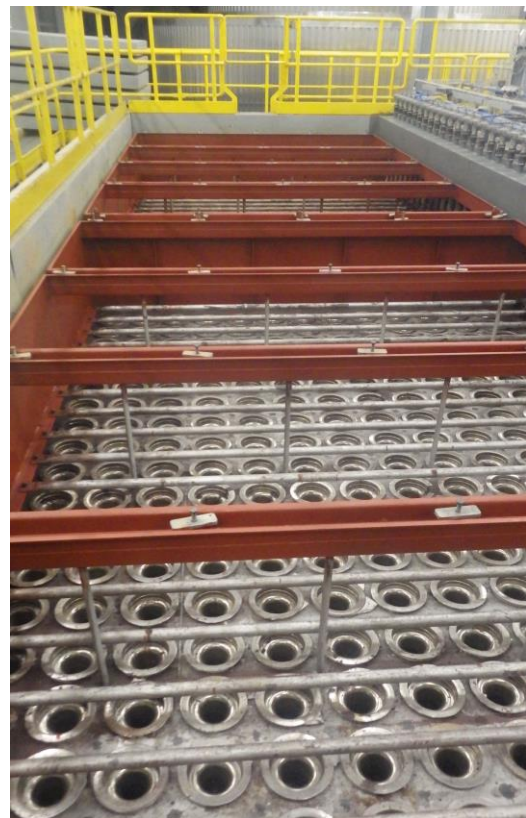
Obrázek 16 Filtrační rukávce
