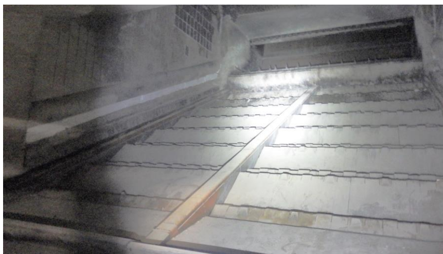
Obrázek 12 Náhled na pohyblivé ližiny roštu v kotli MARTIN VARIO
