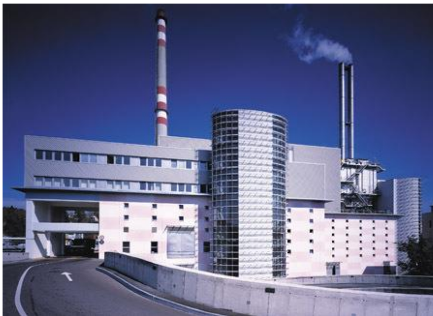
Obrázek 21 Spalovna TERMIZO Liberec [35]
