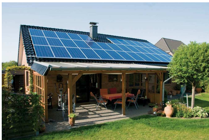
Obr.: 12 - Malá fotovoltaická elektrárna na střeše nízkoenergetického domu [2]
