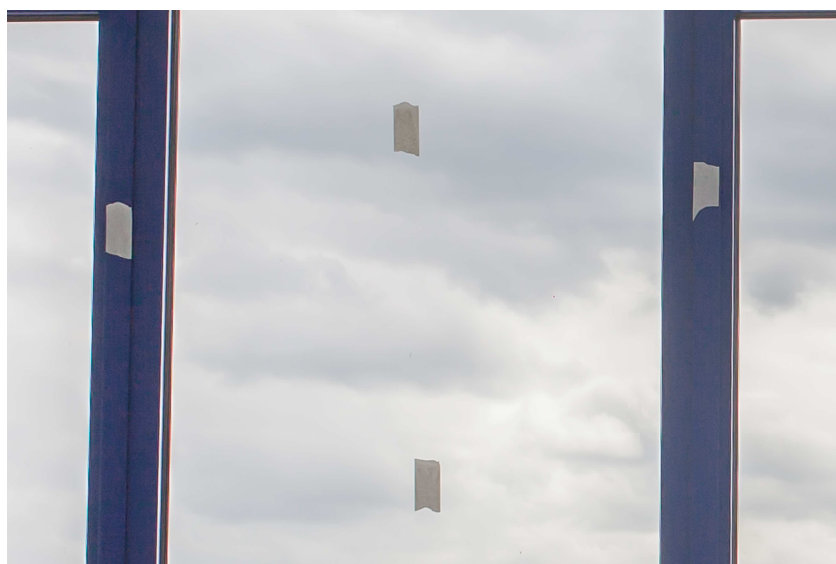
Obr.: 35 - Ilustrační fotografie použití papírových pásek ke vzájemnému přibližnému srovnání emisivit povrchů solárního okna
