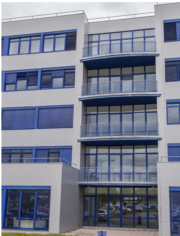
Obr.: 27 - Pohled zvenku na měřená solární okna na měřicích místech EU1, EU3 a EU5
