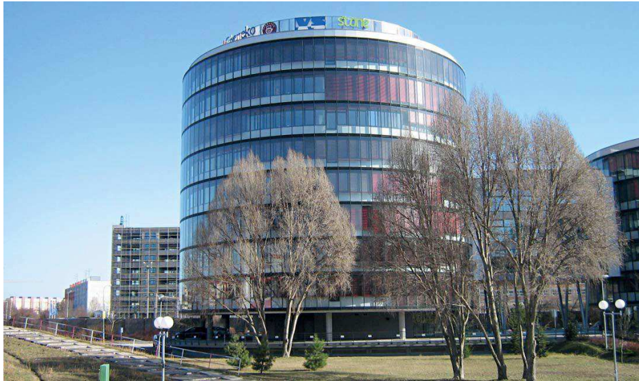
Obr.: 20 - Ukázka využití dvojitě transparentní fasády se zabudovanými stínícími prvky [17]
