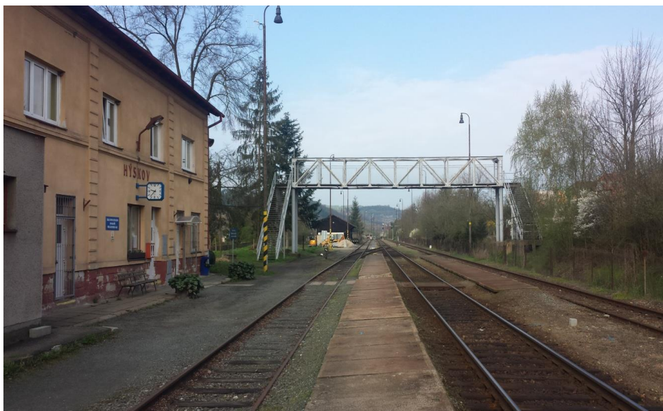
Obrázek 17: lávka na nádraží postavená v rámci „akce Z“ v 60. letech
