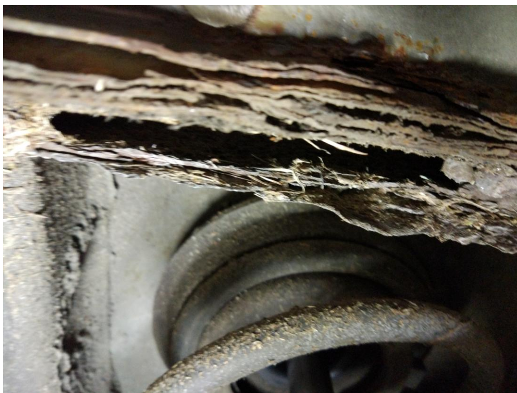
Obrázek 19 - Koroze po oloupení ochranného nátěru
