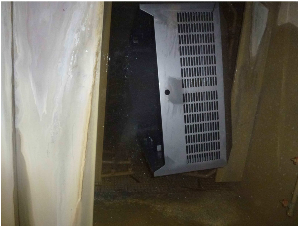
Obr. 28 Vnitřní strana linky
