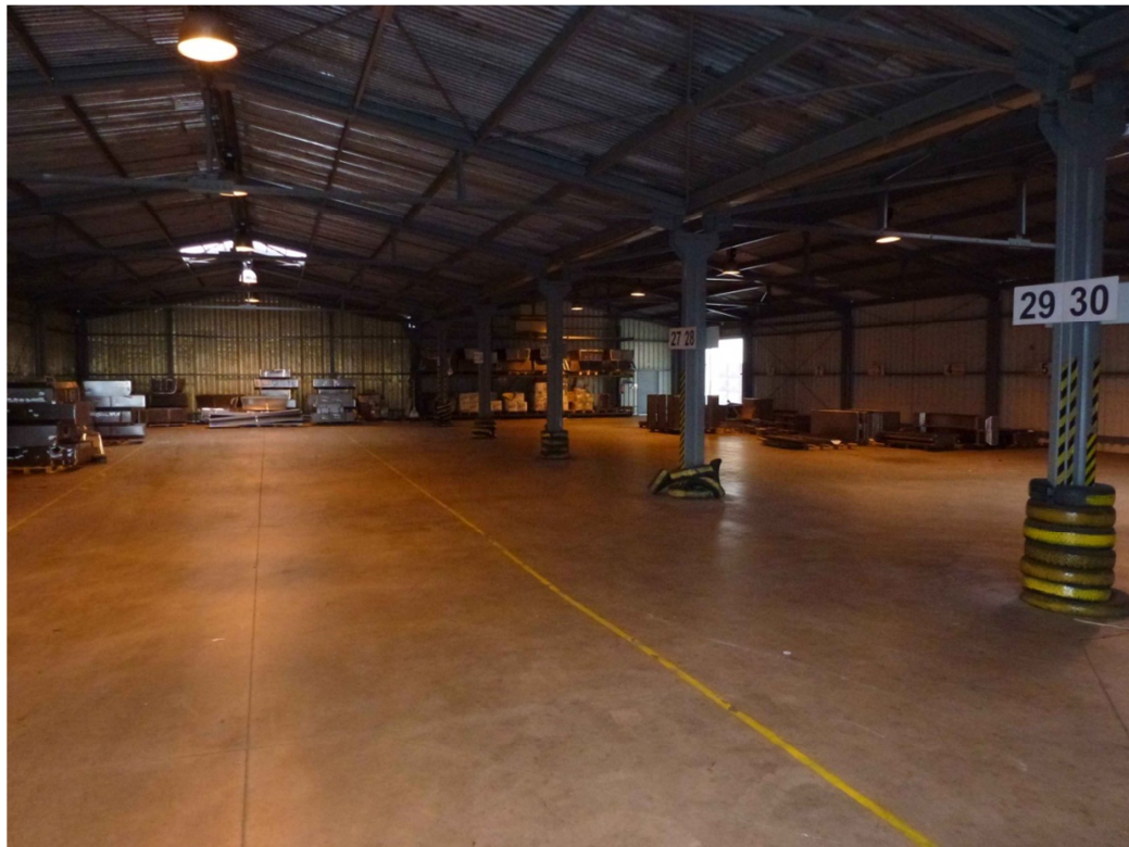
Obr. 17 Hlavní sklad (vnitřní pohled)
