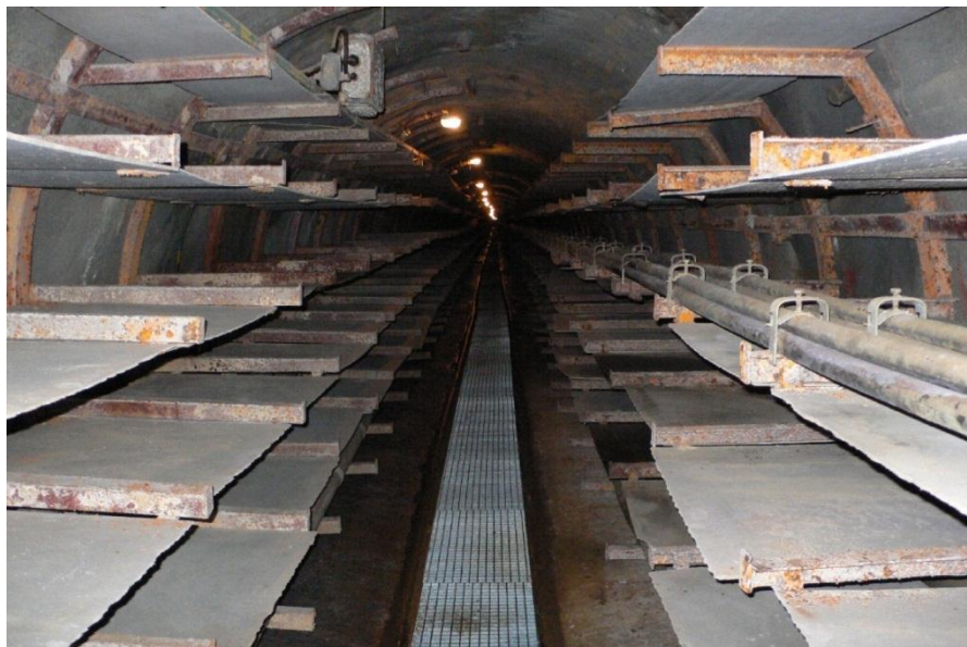
Obr. 1.3 Kabelový tunel Holešovice [6]
