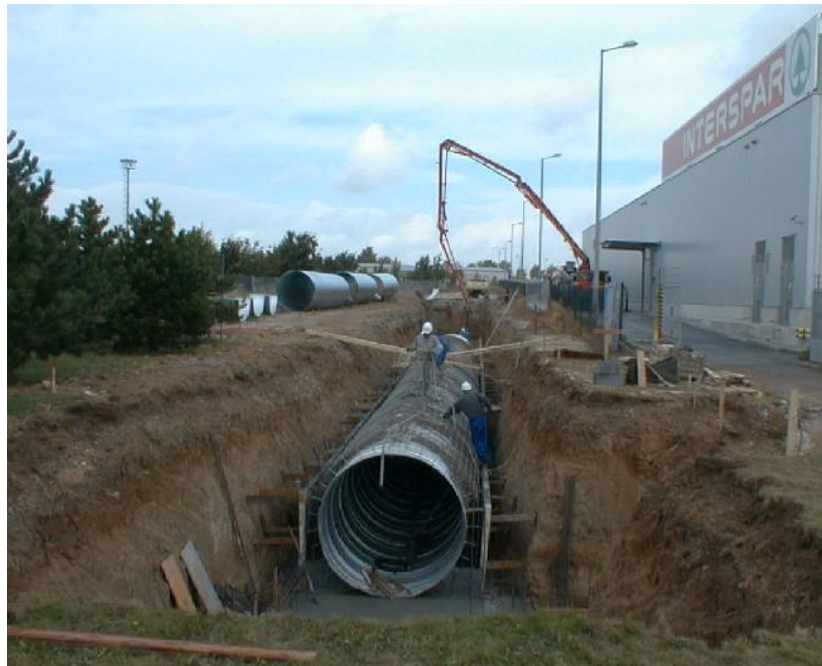
Obr. 1.2 Výstavba Kabelového tunelu Zlín [7]
