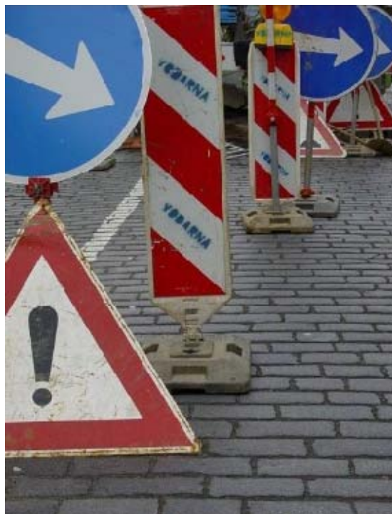
Obr. 12: Podstavce pro dopravní značky v praxi [22]
