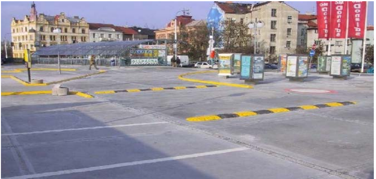
Obr. 11: Vodící a zpomalovací prahy – horní parkoviště u nákupního střediska Kaufland, ul. Otýlie Beníškové, Plzeň [22]
