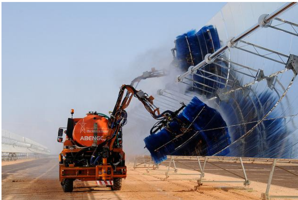
Obr. 49: Čištění heliostatů v Beni Mathar Plant [59]
