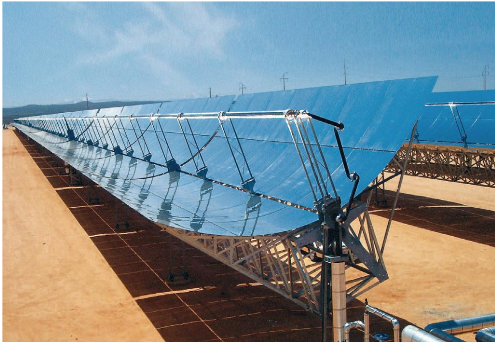
Obr. 20: Heliostaty s absorpční trubicí [25]
