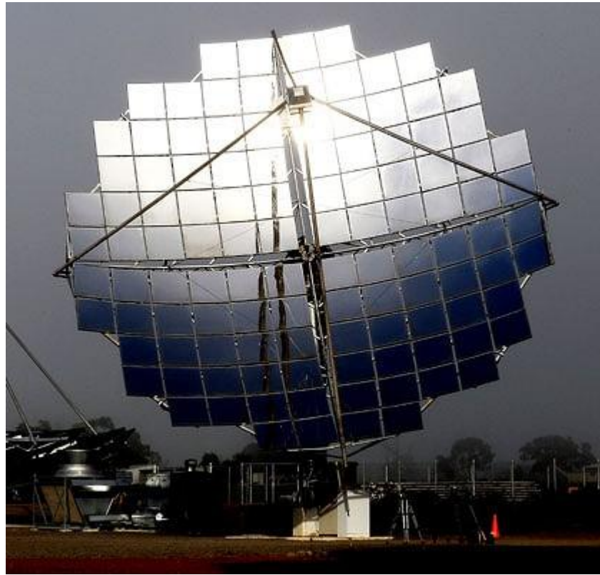
Obr. 46: Solární koncentrátorová fotovoltaická testovací elektrárna Silex u města Bendigo [56]
