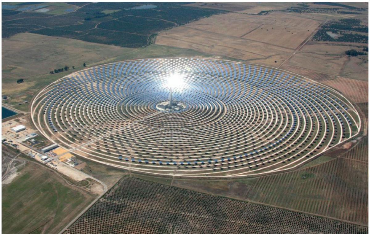
Obr. 21: Věžová solární tepelná elektrárna [25]
