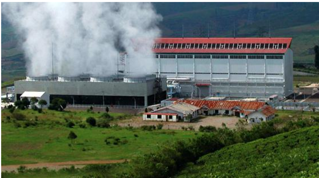
Obr. 55: Geotermální elektrárna Wayang Windu, Indonésie [103]
