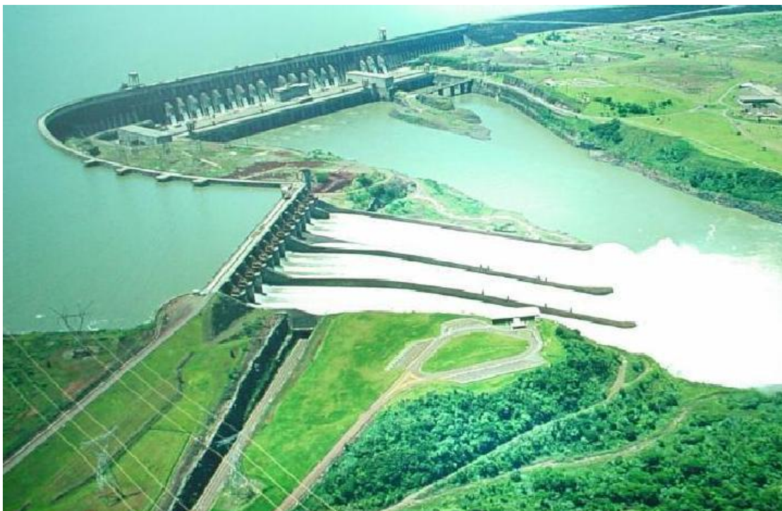
Obr. 67: Elektrárna Itaipu na řece Paraná [9]
