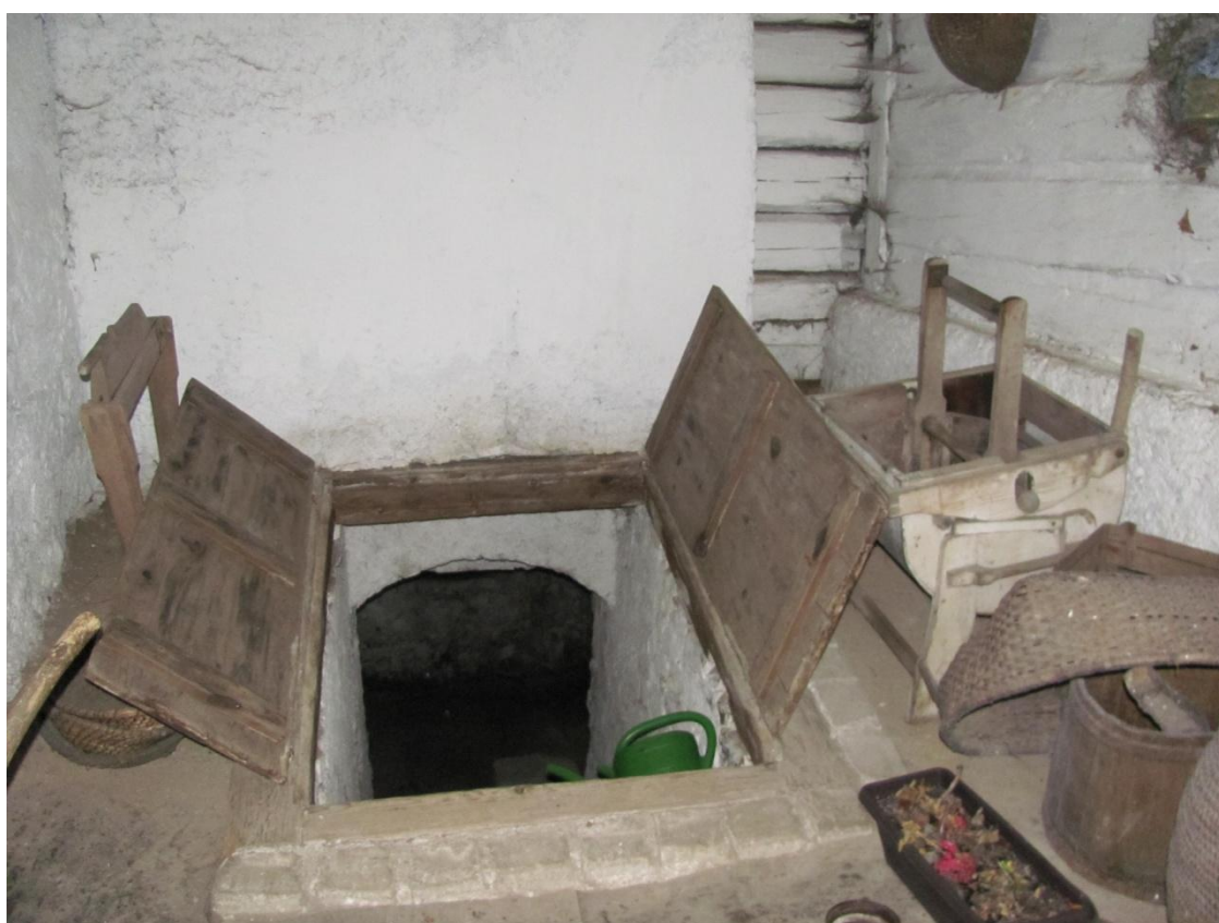
obr. 13 - vstup do sklepa
