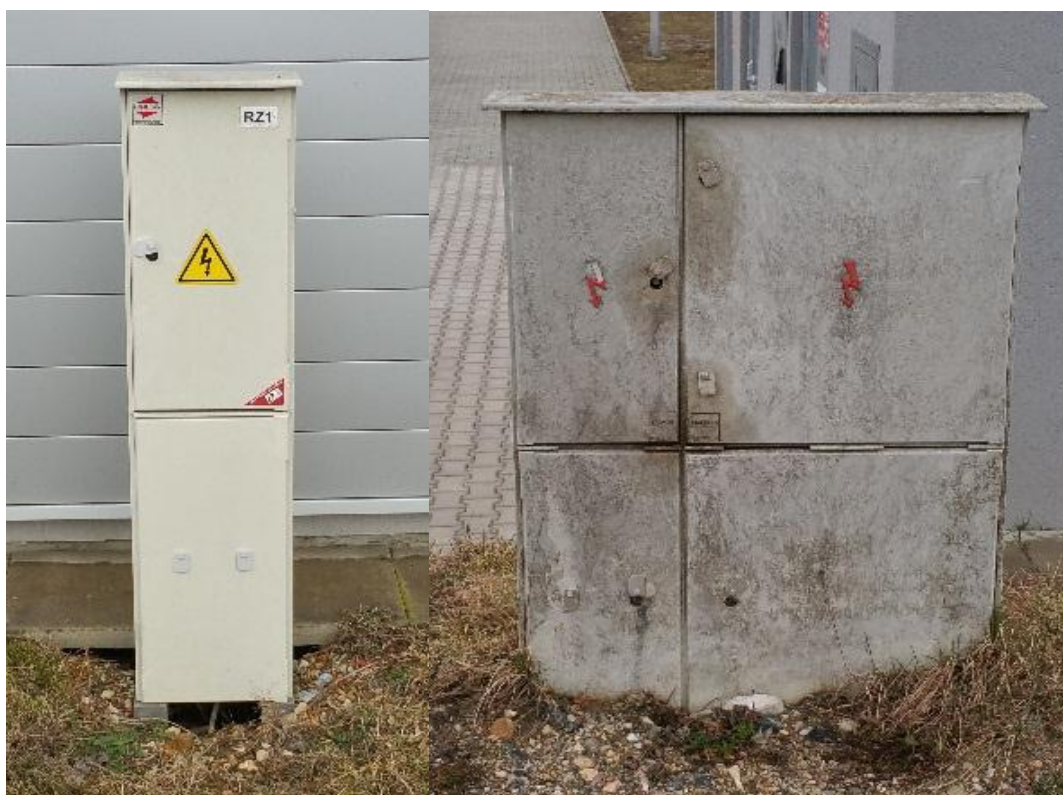
Obr. 3: Rozvaděčové skříně v různém stádiu degradace v okolí FEL ZČU
