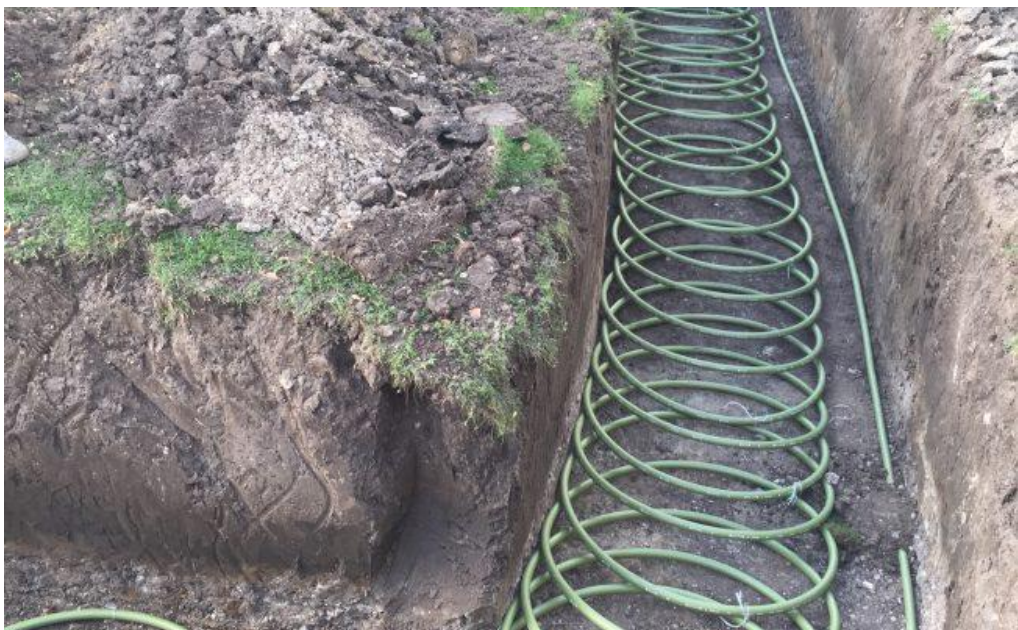
Obr. 12 – Kolektor realizovaný slinkami
