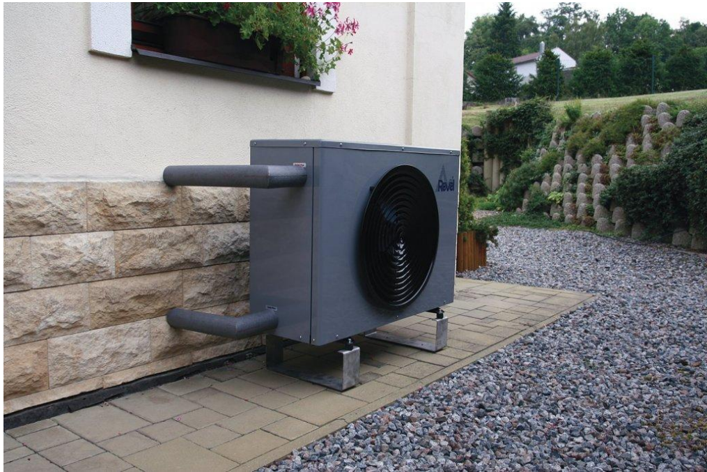
Obr. 9 – Umístění venkovní části tepelného čerpadla vzduch-voda [12]
