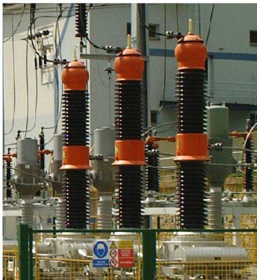
Obrázek 2.15 Máloolejový vypínač [20]
