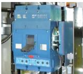
Obr. 2.2.2 Jistič v rozvodové skříni [6]
