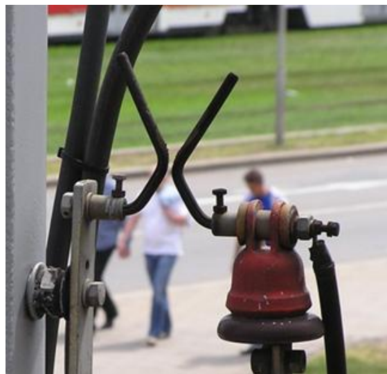
Obr. 2.4.2 Jiskřiště tramvajové troleje [9]
