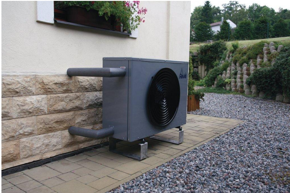
Obr. 9 – Umístění venkovní části tepelného čerpadla vzduch-voda [12]
