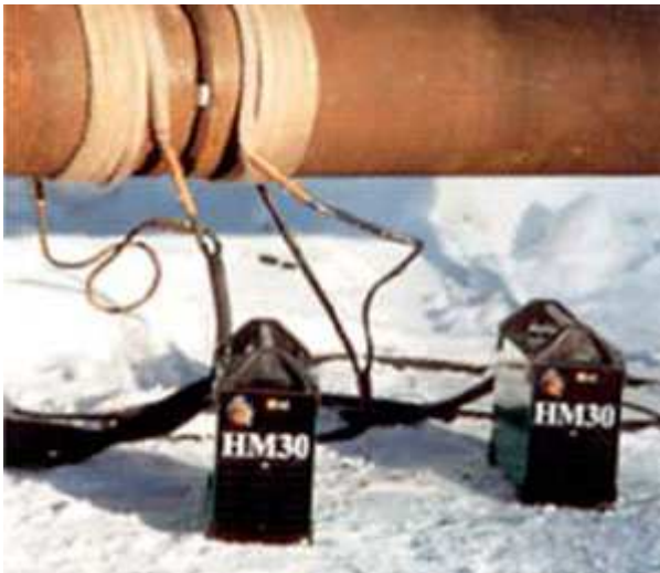
Obr. 2.18 Indukční žíhání obvodového svaru potrubí se zdrojem HM30 [18]
