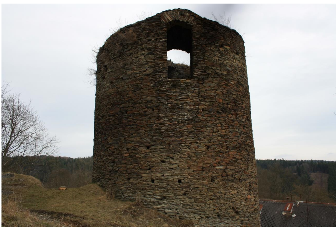
Obr. 26: Dnešní podoba bergfritu. Patrné kapsy po lešení či schodišti. Pohled od západu.
