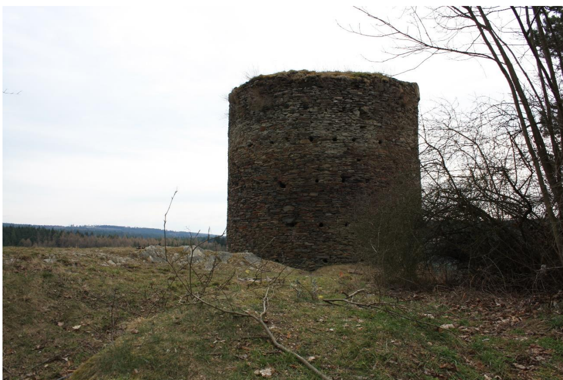
Obr. 28: Pohled na bergfrit od severu. Po obvodu věže patrné kapsy po ukotvení lešení.
